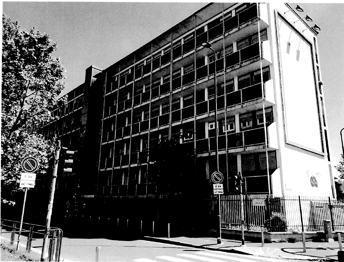
Fronte su Via Dessié
