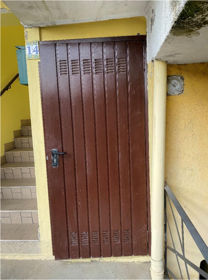
Porta di accesso alla cantina
