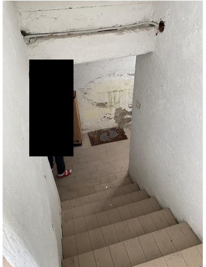
Scala di accesso alla cantina
