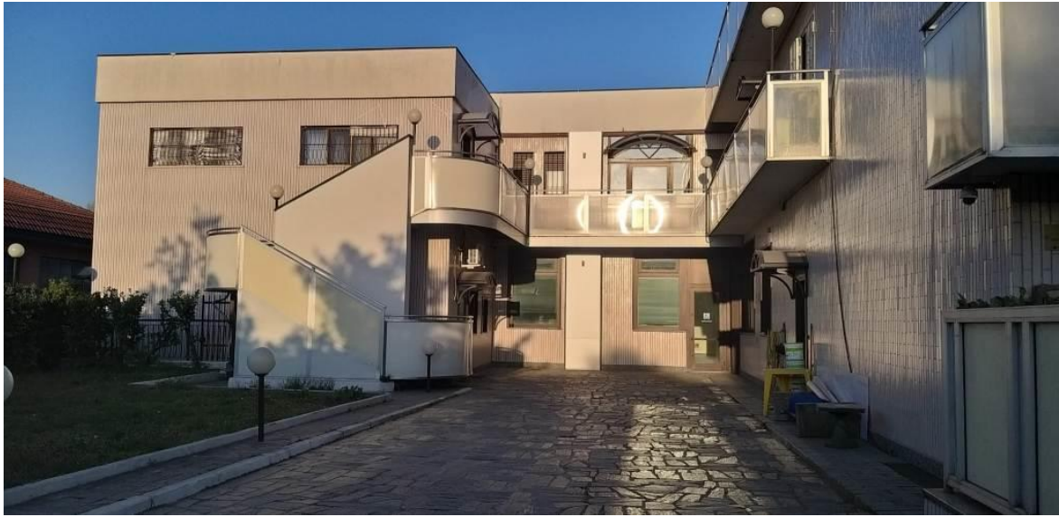
VISTA DEL COMPLESSO
