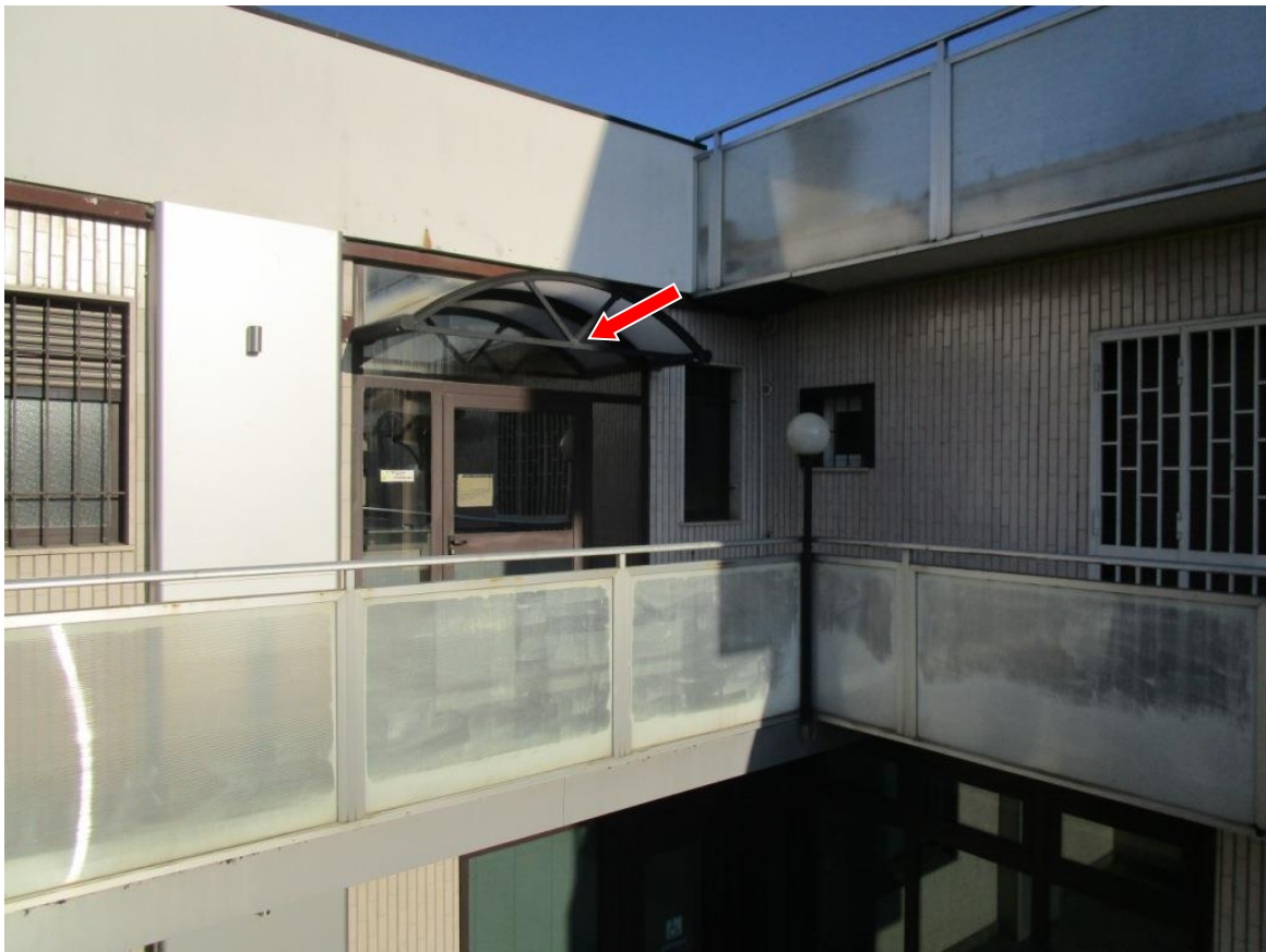
BALLATOIO COMUNE E INGRESSO
