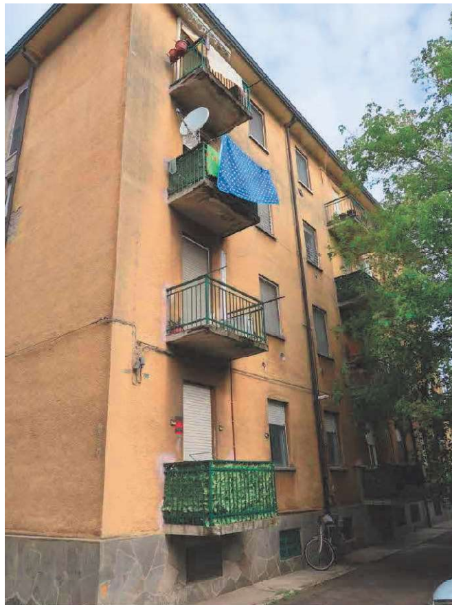
FACCIATA SU CORTILE INTERNO
