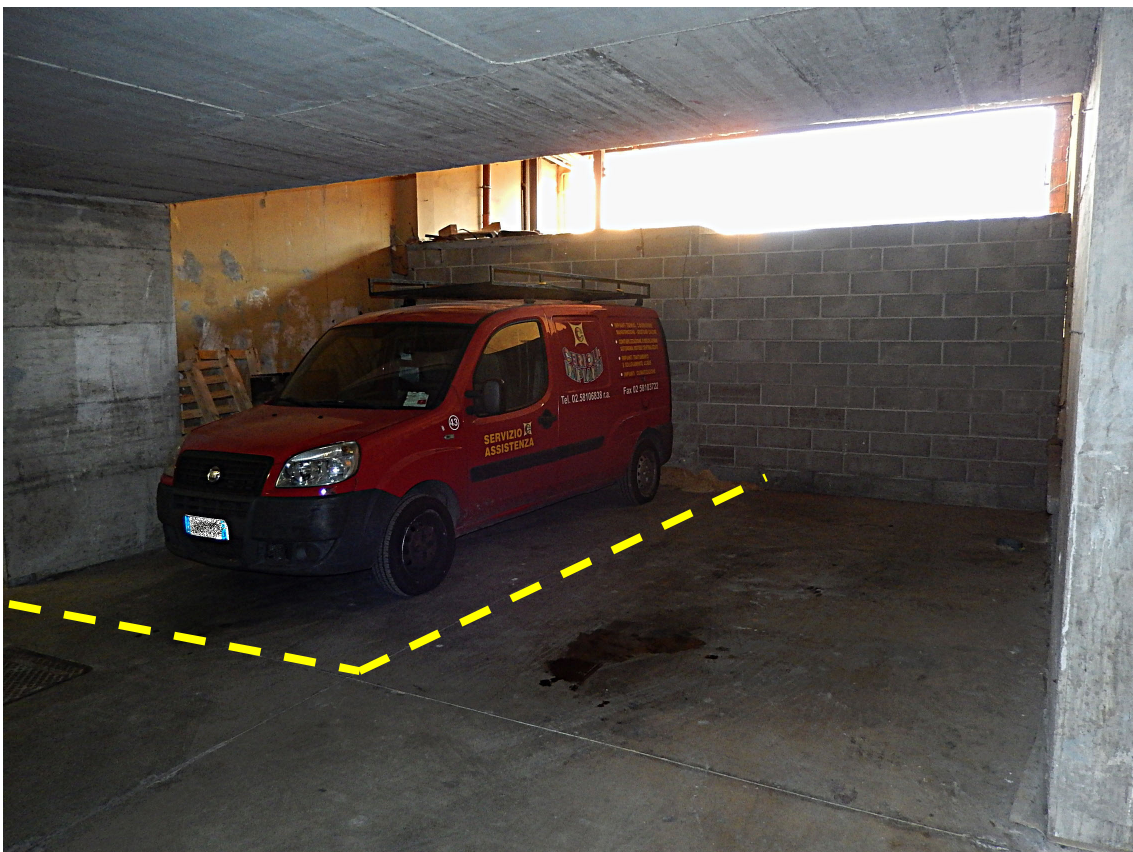
Foto 4 – Il posto auto evidenziato dalla linea tratteggiata.
