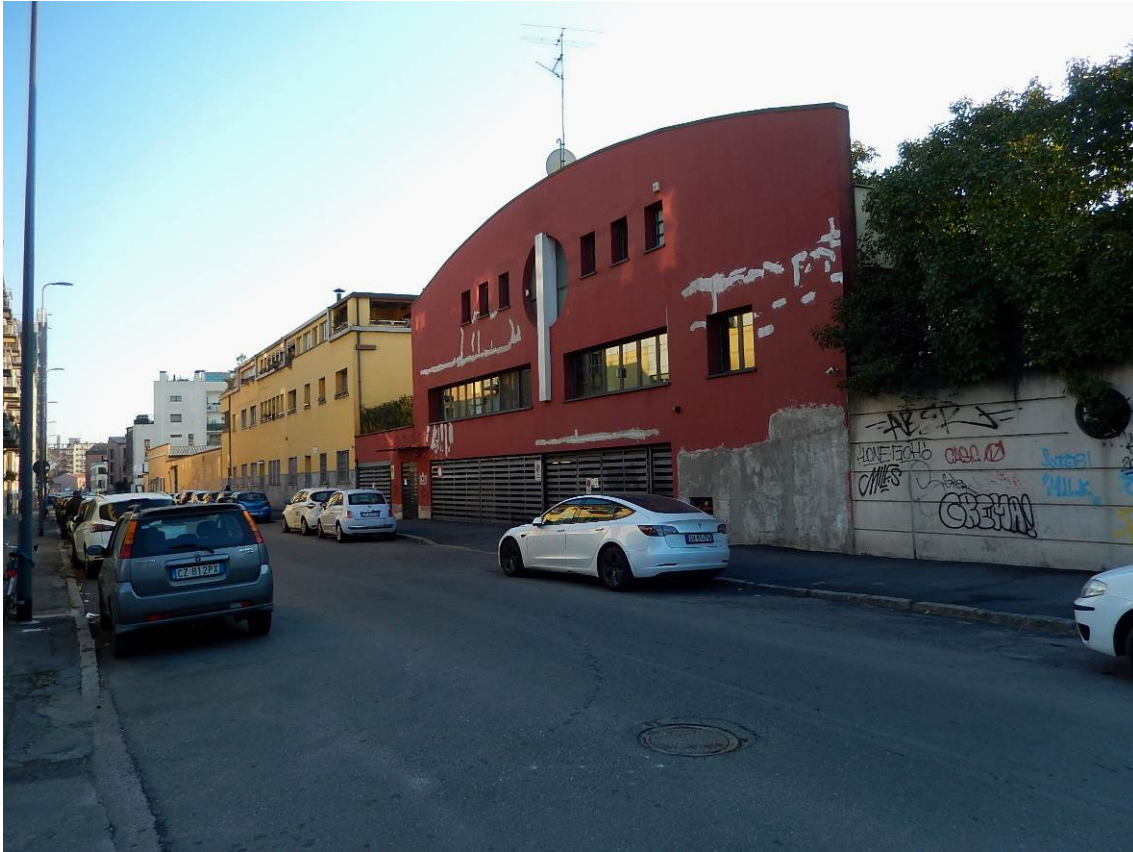
Foto 1 – Vista della facciata sulla via Guintellino.
