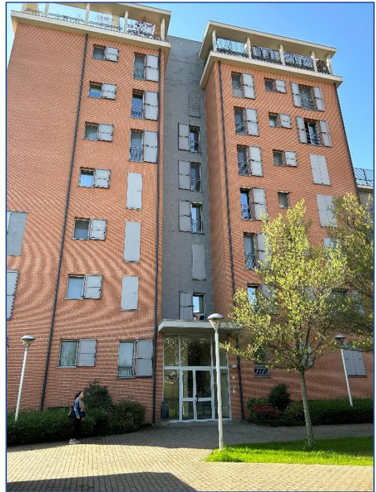
Foto 1 - Immobile via Oberdan n. 1 - scala C
