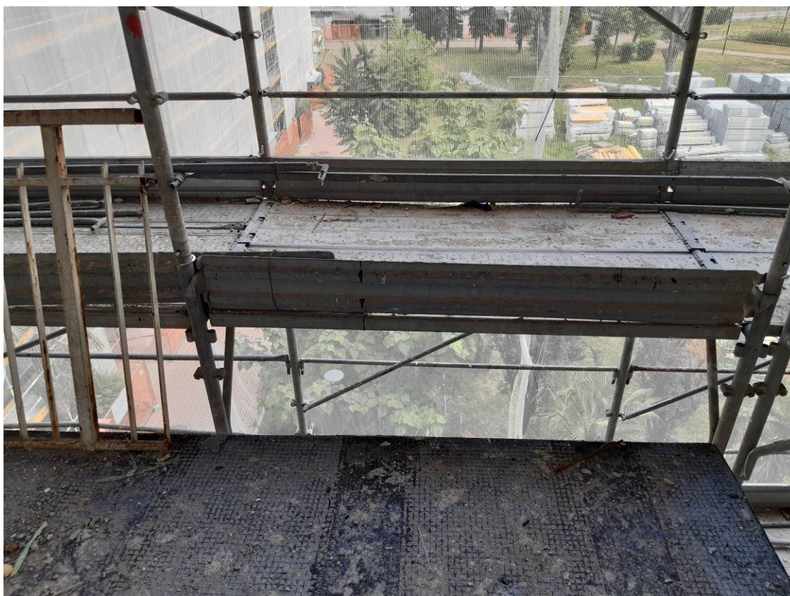
Foto 6 – Vista del balcone della cucina.
