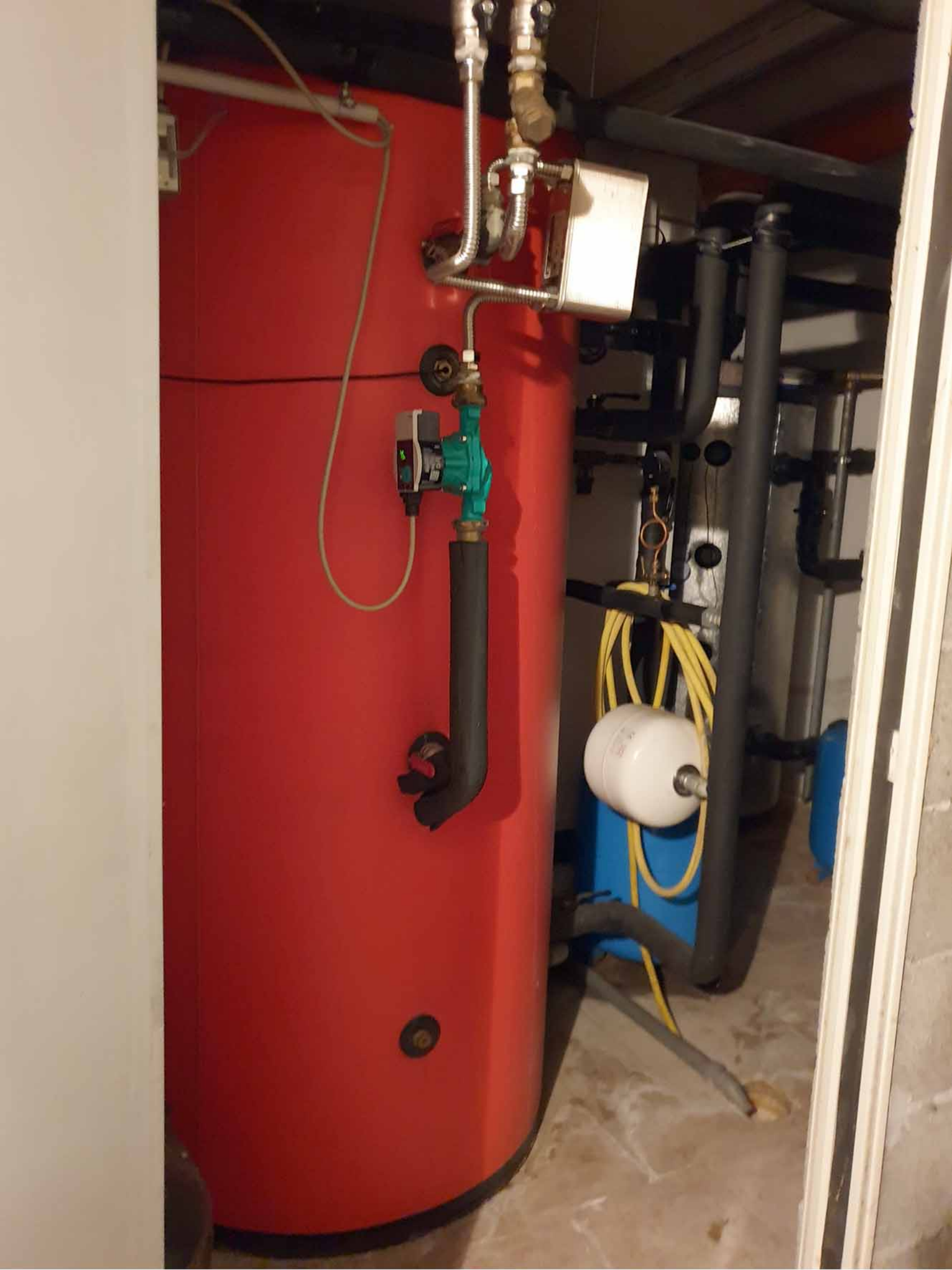
CENTRALE TERMICA NON IN USO
