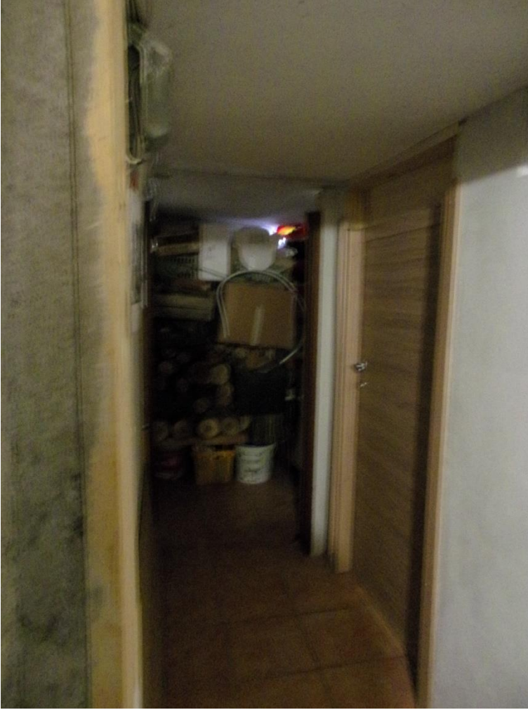
Foto 19: spazio comune prima della cantina
