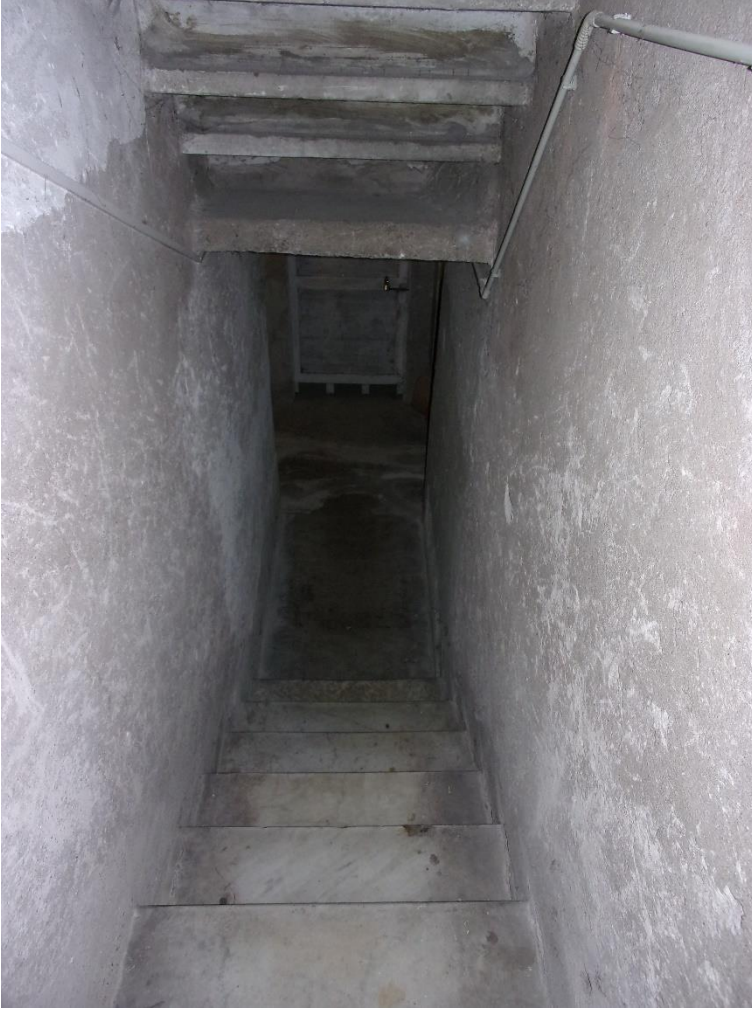
Foto 17: scala comune accesso piano cantine
