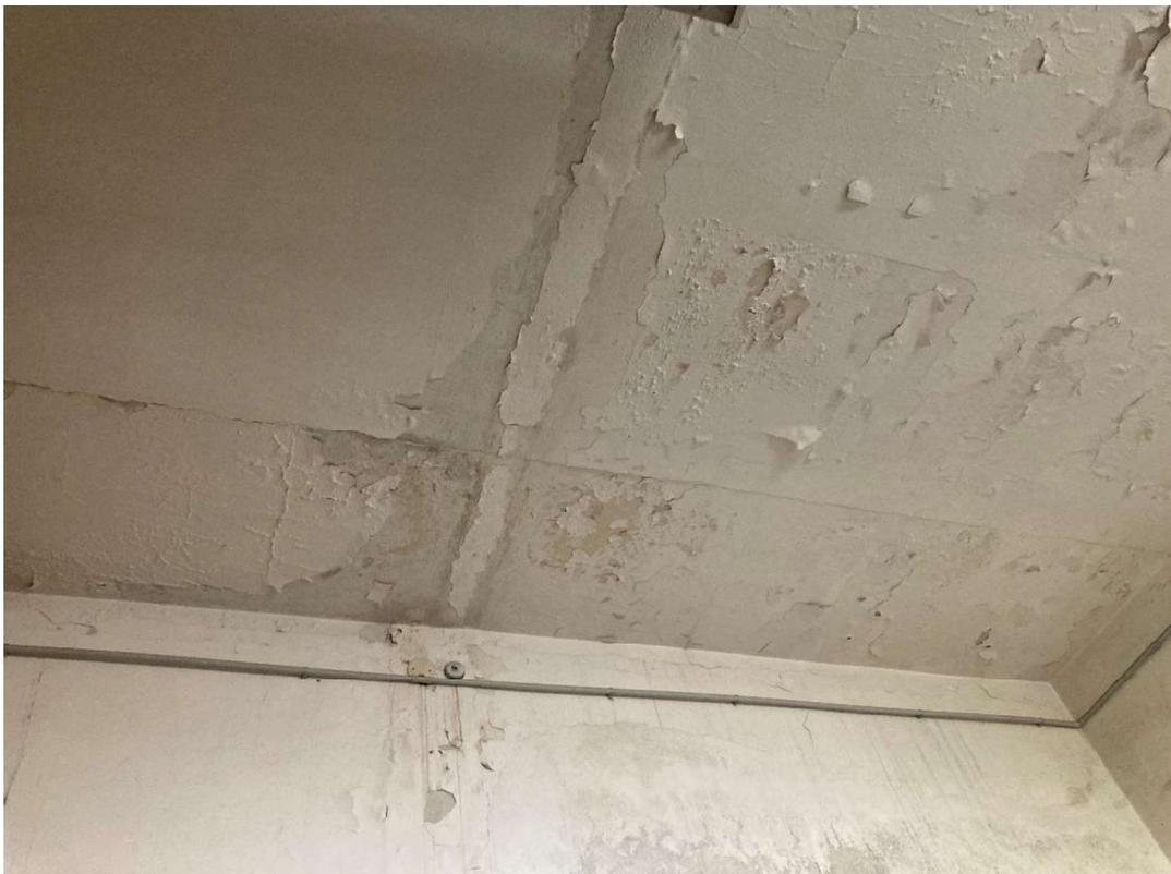
Foto n. 6: Dettaglio ammaloramenti a parete e a soffitto
