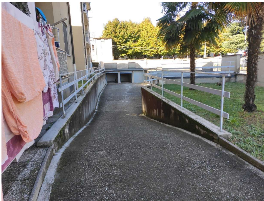
Foto 17 – Rampa e piazzale dei box
