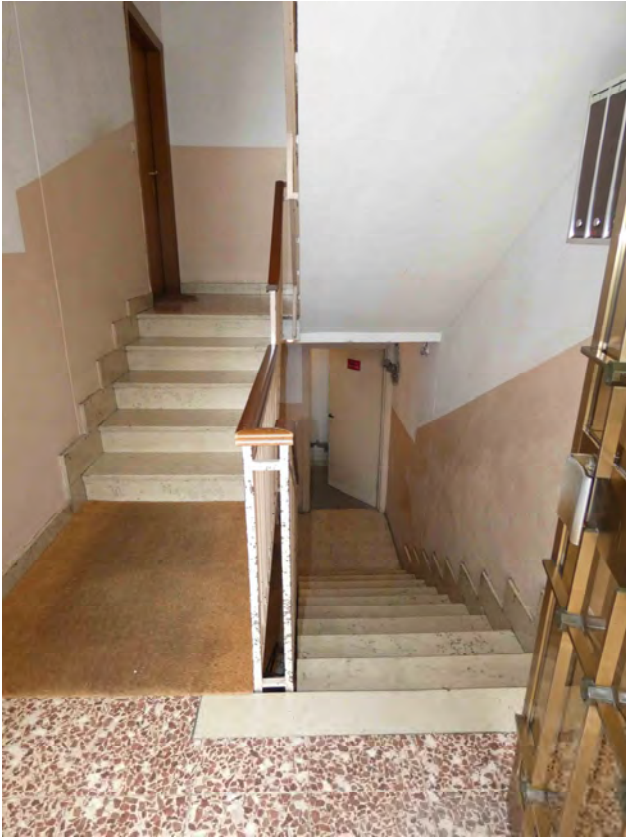
Foto 5. Androne d'ingresso e scala d'accesso cantine
