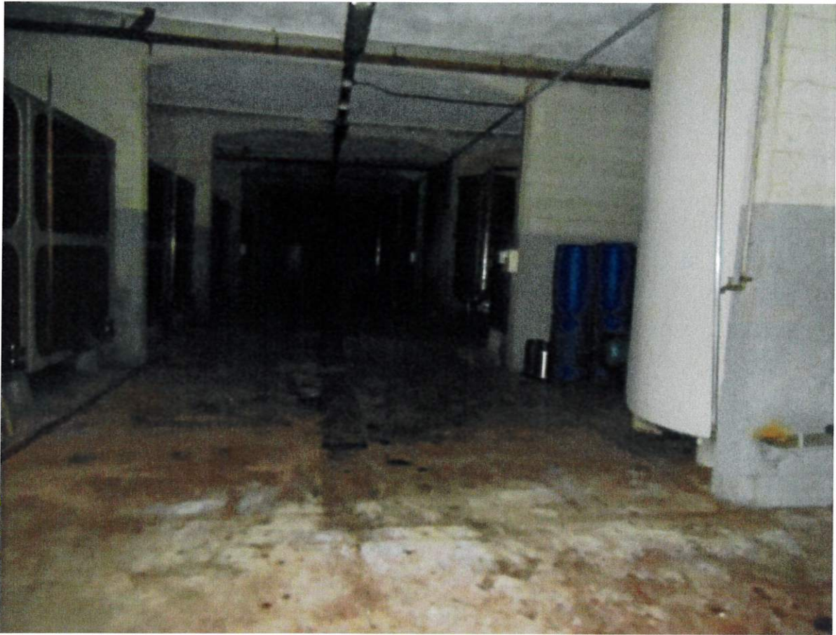
Foto 7: deposito vini sfusi
