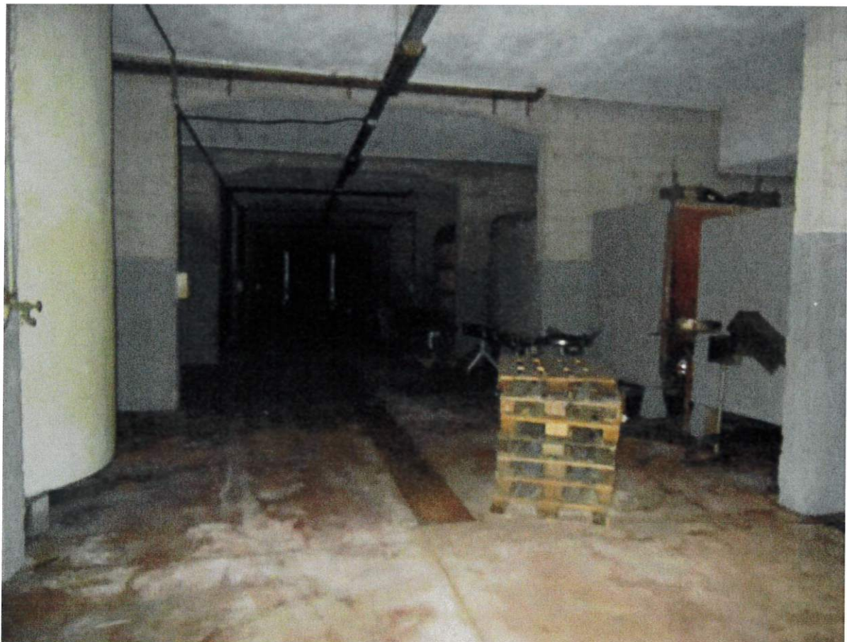
Foto 8: deposito vini sfusi
