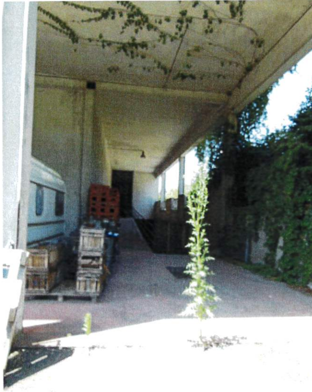
Foto 5: rampe d'accesso al piano rialzato e cantinato
