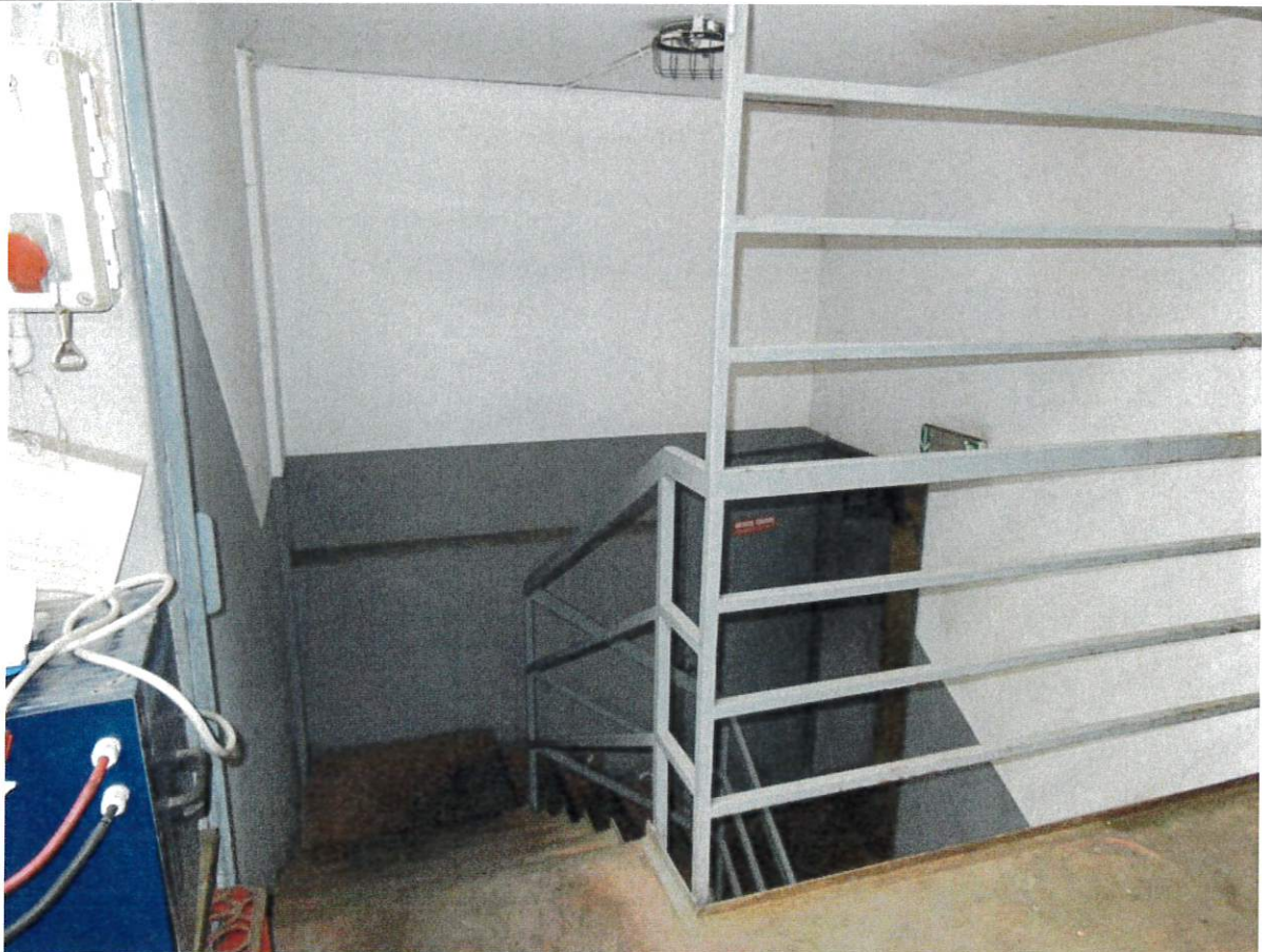
Foto 16: sbarco scala al piano rialzato
