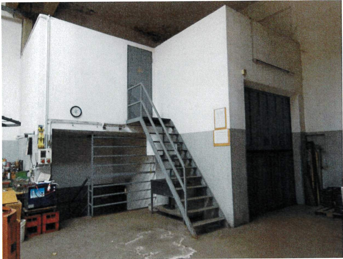
Foto 17: montacarichi e locale tecnico montacarichi
