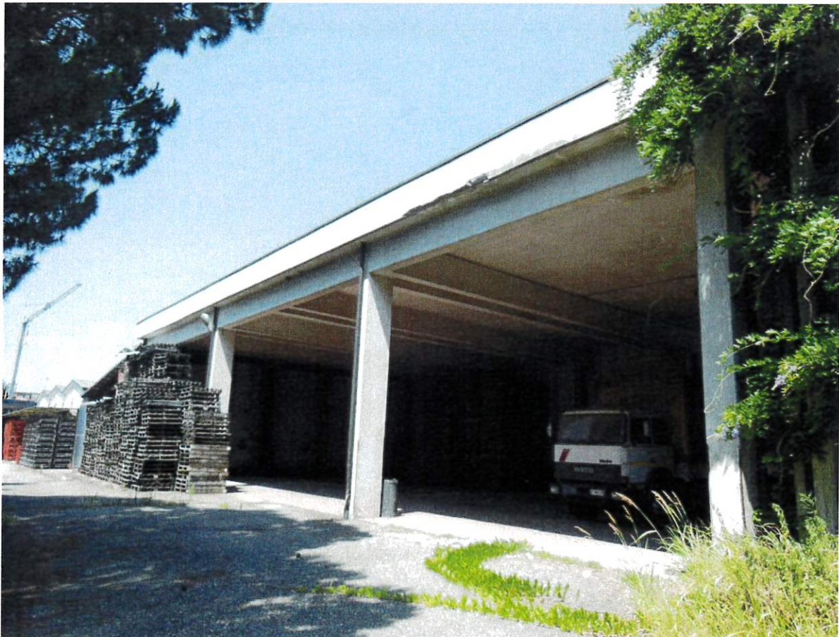
Foto 2: portico lato sud
