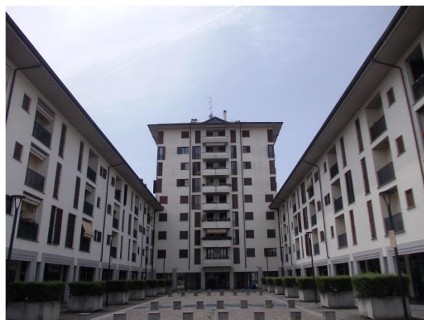
Sopralluogo effettuato in data 21/06/2023
