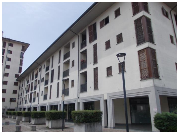
Sopralluogo effettuato in data 21/06/2023
