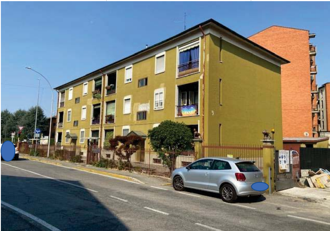
VISTA DALLA VIA
