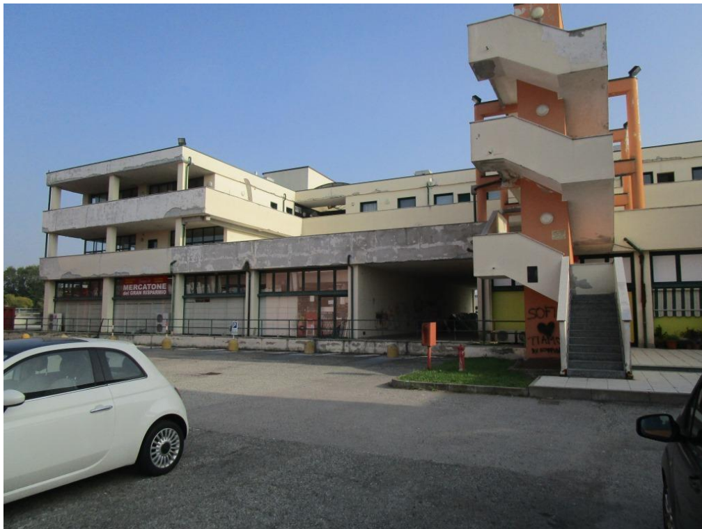
Foto 1 – Vista del complesso immobiliare
