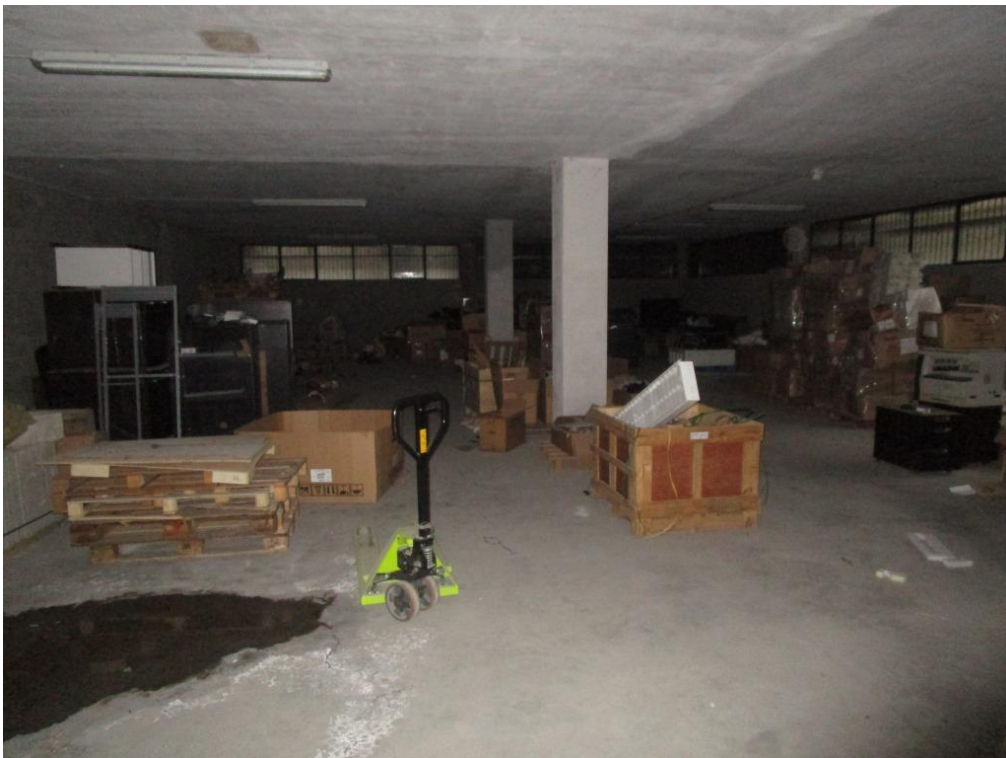
Foto 11 – Deposito sub 724 (porzione B)
