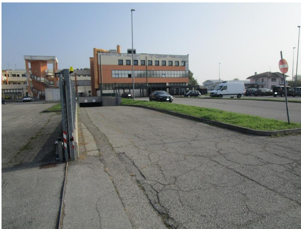
Foto 3 – Vista della rampa di accesso al piano interrato
