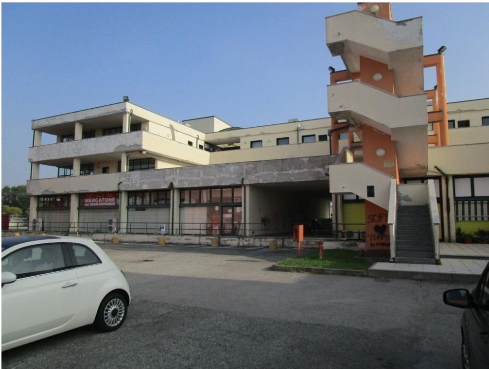
Foto 1 – Vista del complesso immobiliare
