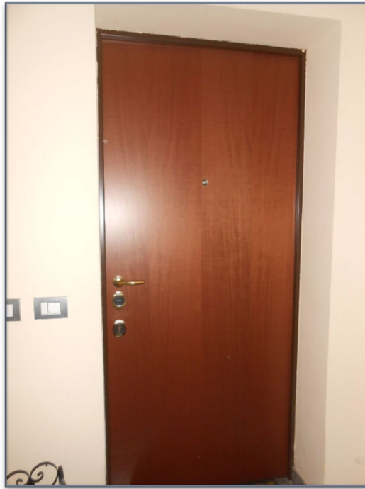
Foto 5 porta ingresso all'appartamento
