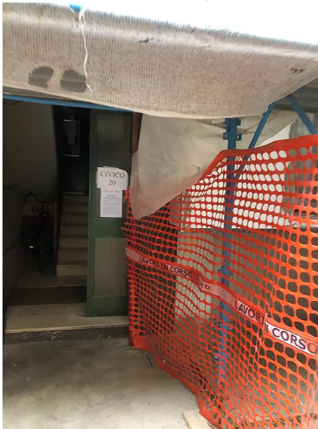
VISTE ACCESSO AL FABBRICATO
