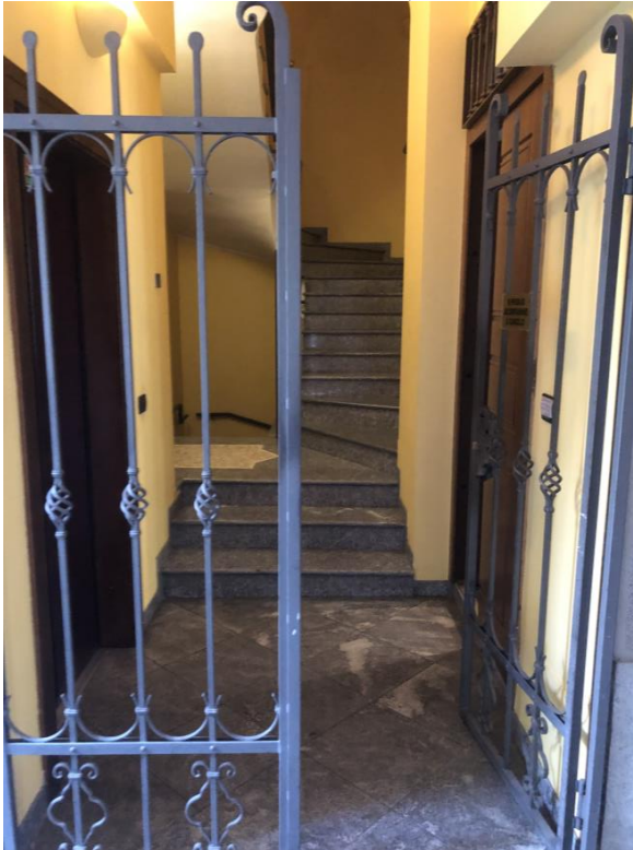
VISTA VANO SCALA
