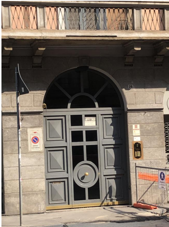
VISTA PORTONE INGRESSO
