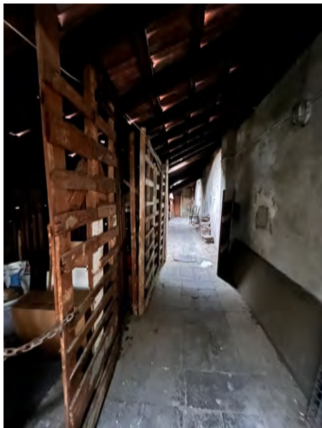
Immagini 11 e 12. Attraverso le scale si raggiunge l'ultimo piano sottotetto, in parte già recuperato a residenza. Una porta consente l'accesso al corridoio su cui si aprono le porzioni di solaio di pertinenza degli appartamenti che sono delimitate con separazioni trasparenti in legno.
