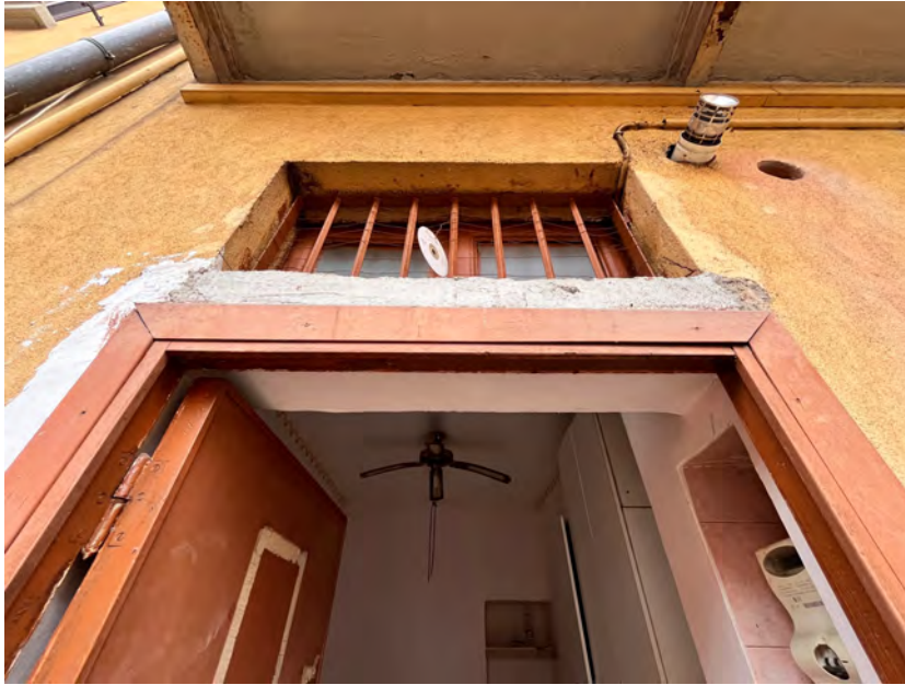
Immagine 7. L'ingresso: porta a doppiobattenti con sopraluce; nell'imbotte, all'interno di una nicchia, è inserito il contatore elettrico.
