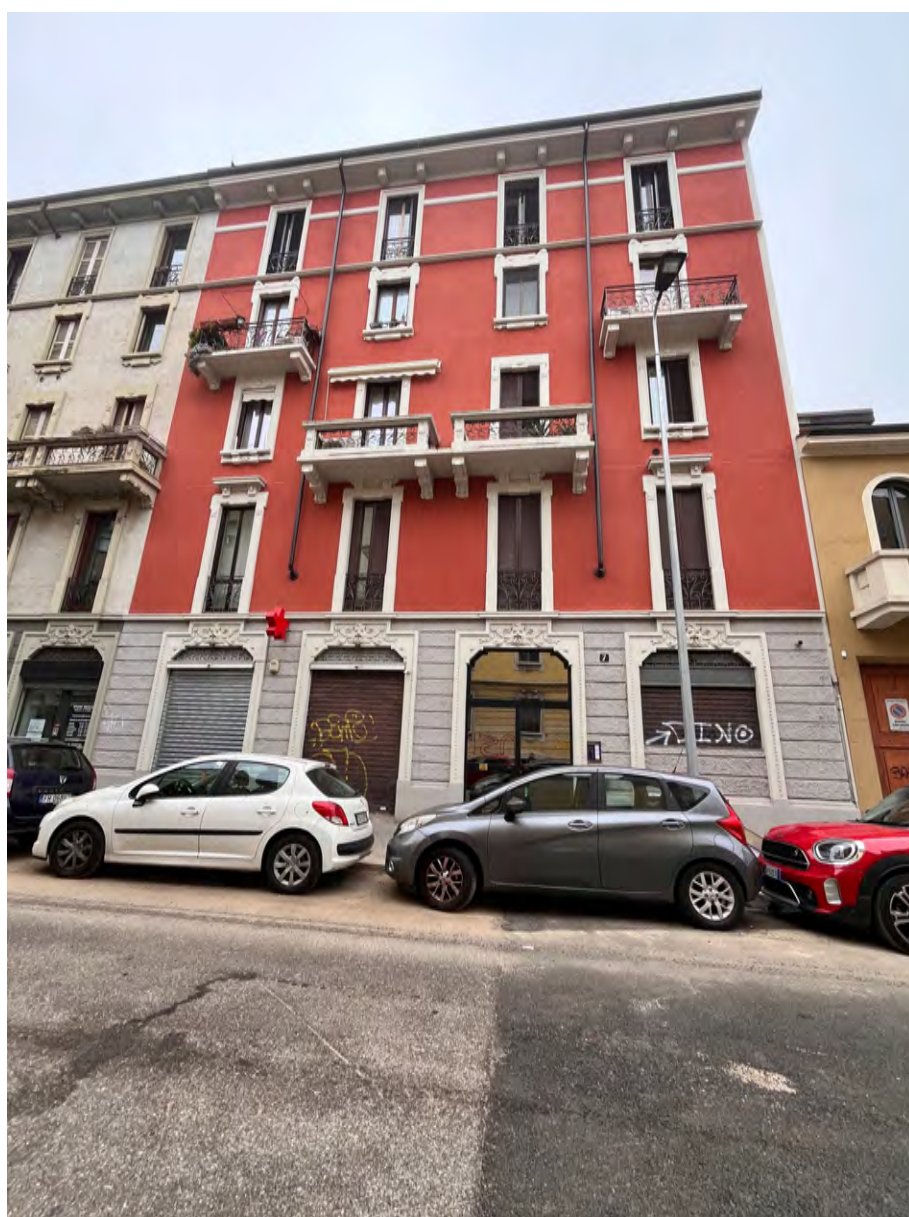
Immagine 0. Il fabbricato visto dalla strada.
