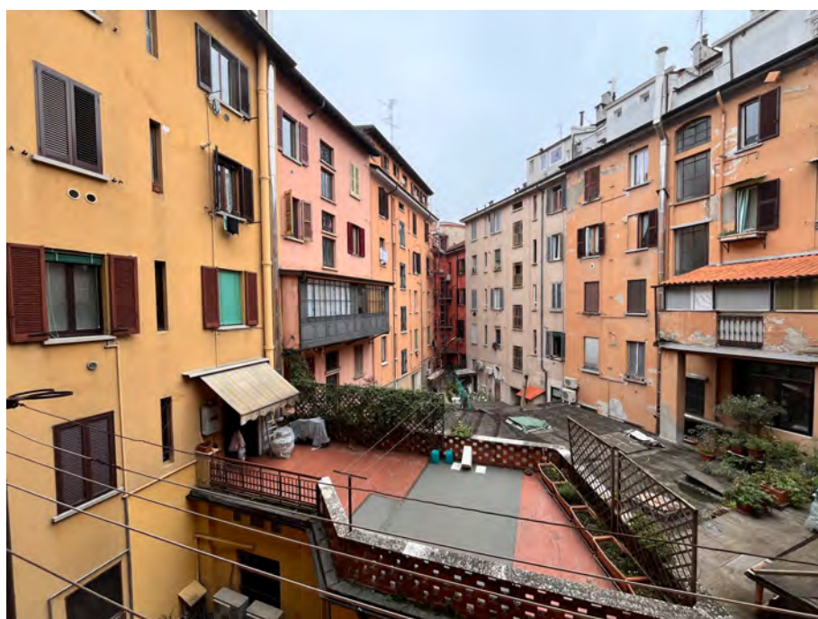
Immagini 5 e 6. Il ballatoio e il cortile visto dall'alto.
