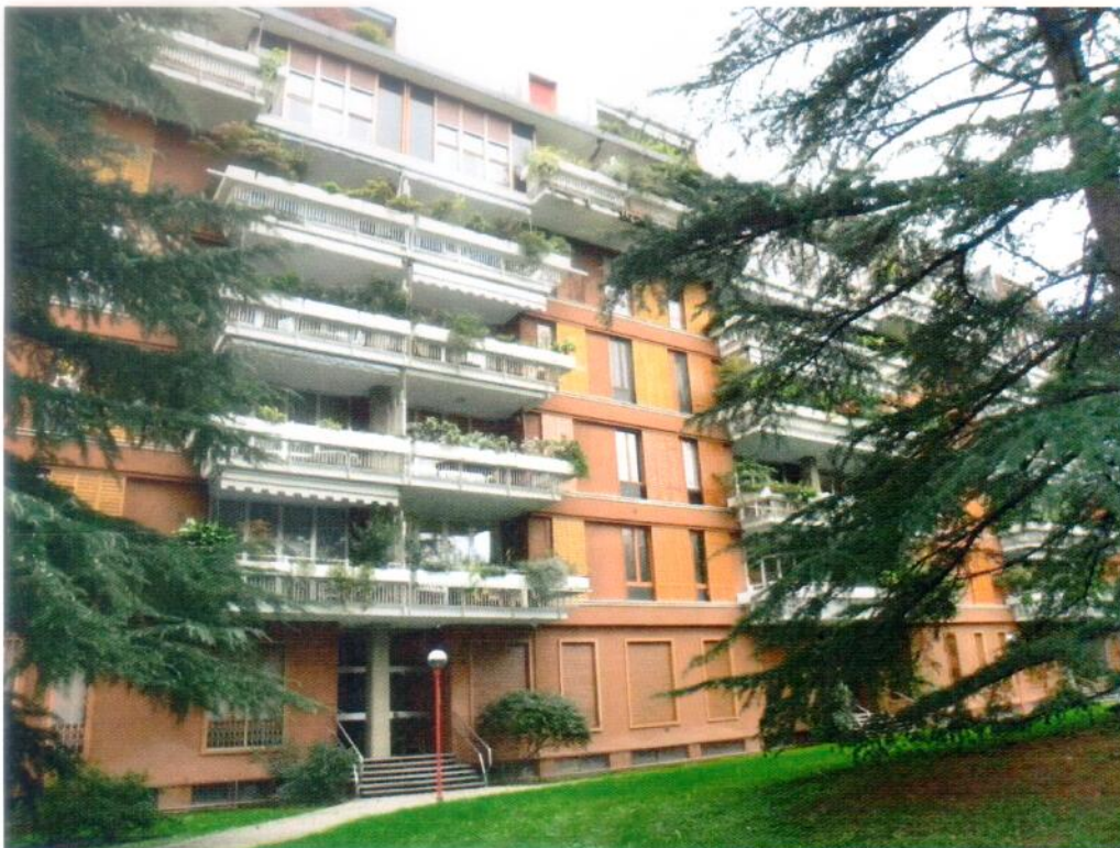
Vista esterna del fabbricato
