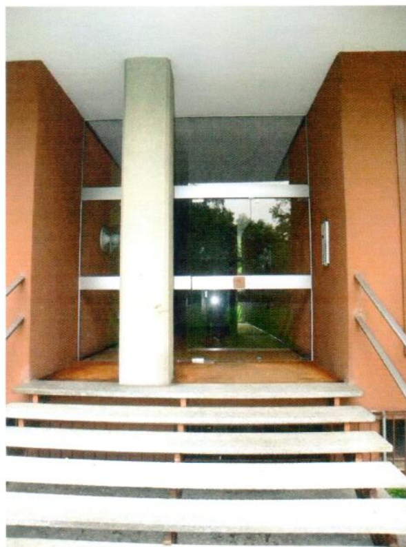
Vista esterna – Ingresso del fabbricato
