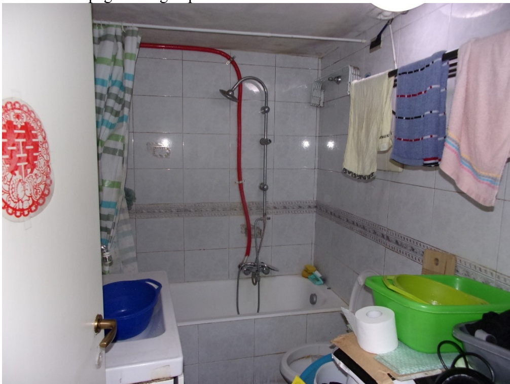
Foto 6: bagno piano terra
