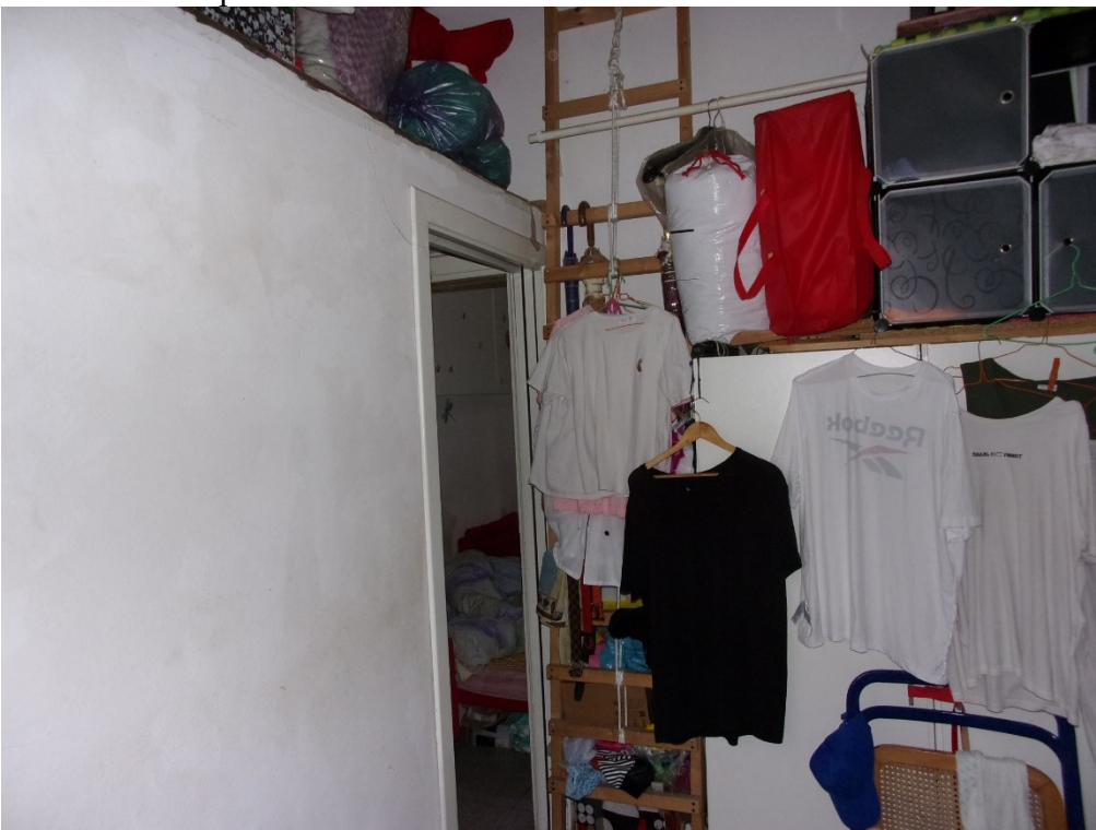
Foto 8: camera piano terra
