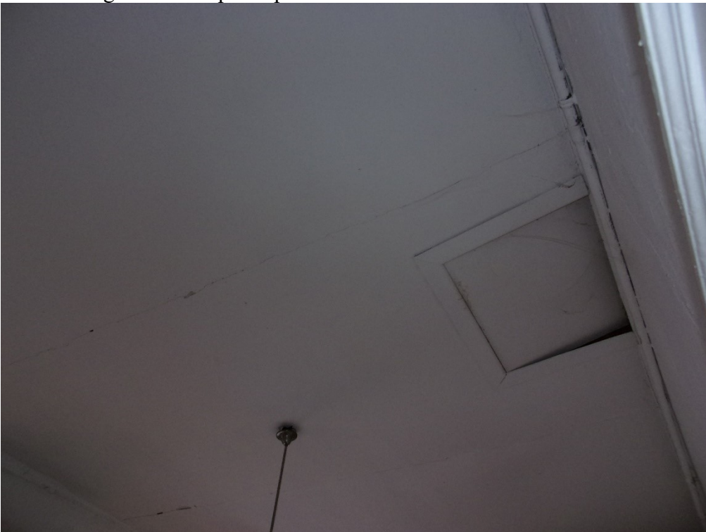
Foto 19: botola accesso sottotetto
