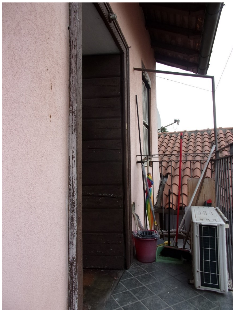
Foto 10: ingresso piano primo
