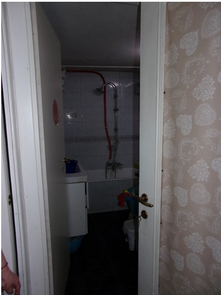
Foto 5: disimpegno – bagno piano terra
