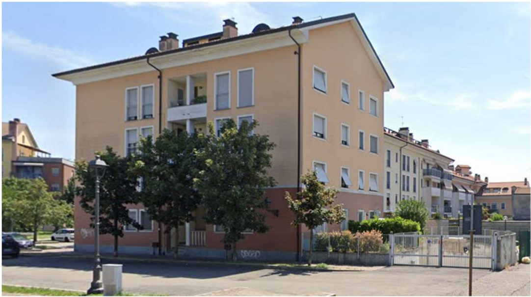
Foto 16 – Prospetto ingresso ai box
