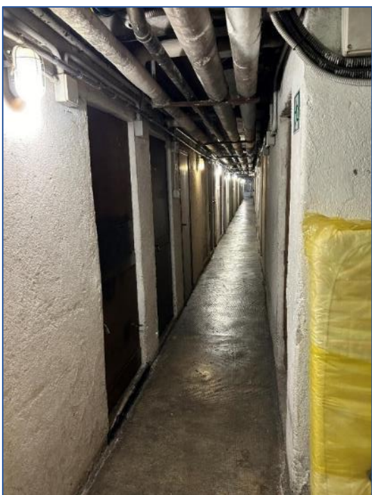
Foto 15 - corridoio comune piano S1
