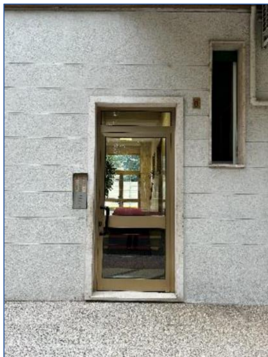
Foto 6 - ingresso comune su corte interna
