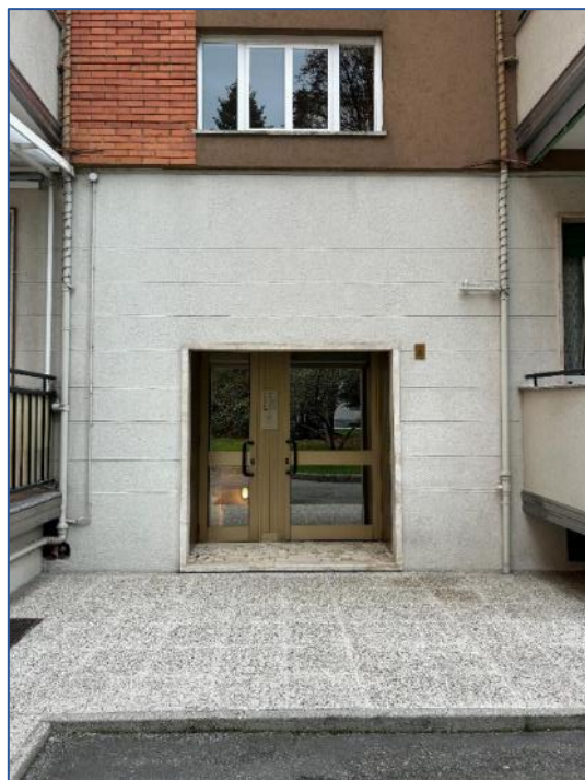
Foto 10 - ingresso comune su corte interna
