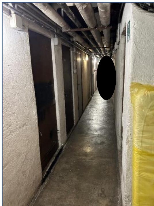
Foto 14 - corridoio comune piano S1
