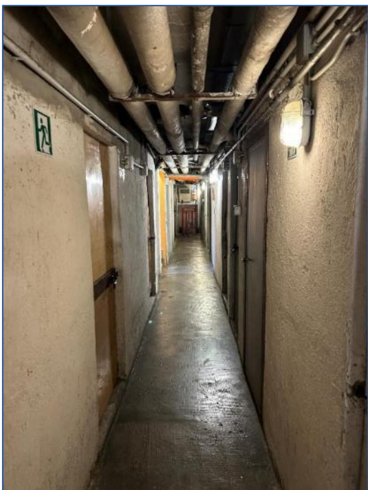
Foto 13 - corridoio comune piano S1
