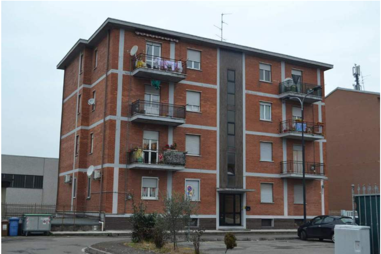
FOTO N. 1 – ESTERNO: Edificio condominiale di Via Alberto da Giussano, 12
