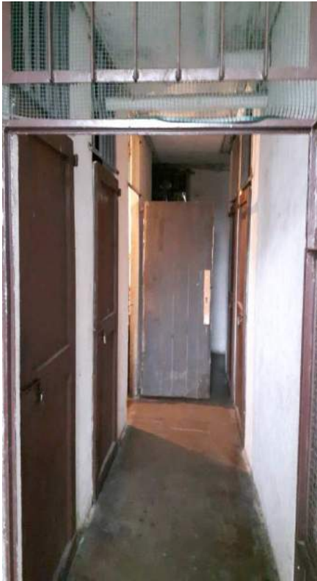
FOTO N. 13 – Disimpegno comune cantine
