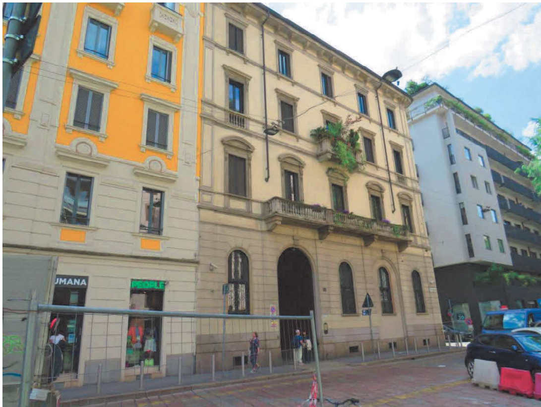
FACCIATA SU VIA DE AMICIS
