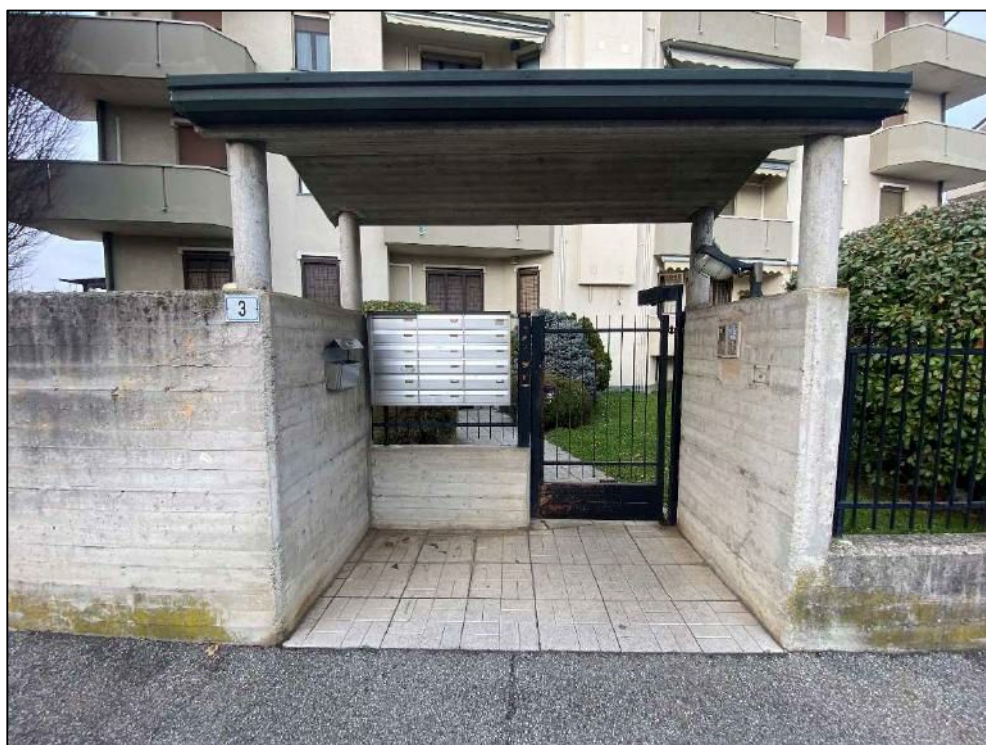
Foto n°4 – Accesso pedonale dal civ.3 della Via Giuseppe Mazzini
