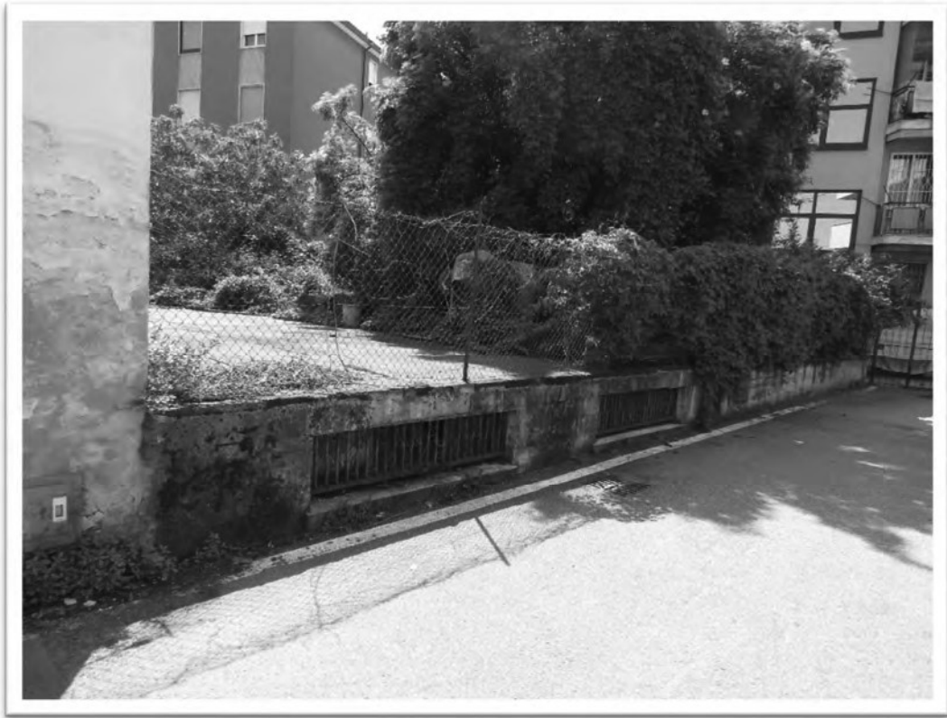
Particolare dell'area scoperta pertinenziale e della copertura dei boxes.
