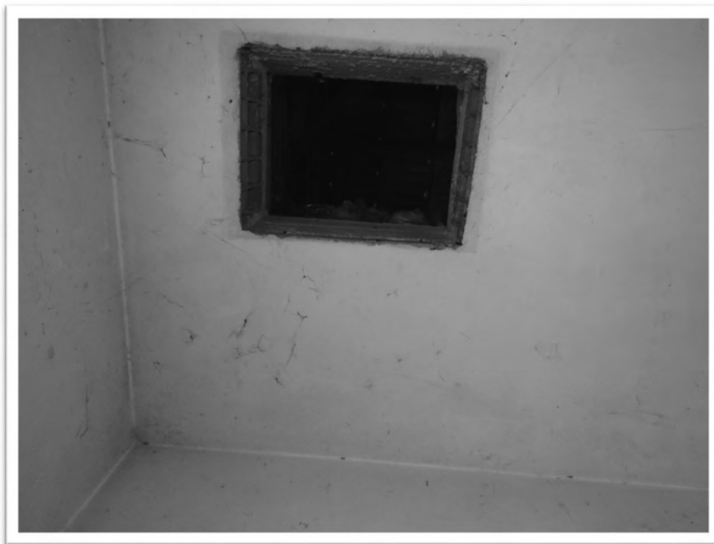
La botola di ispezione del sottotetto e particolare della parete del pianerottolo del piano 1°.
