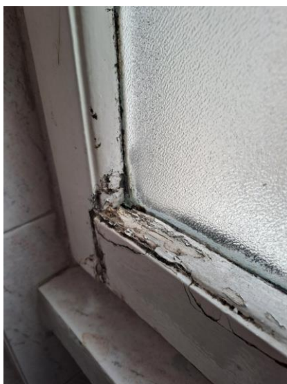
25. Serramento esterno del bagno
