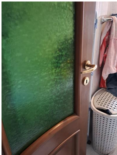
31. Dettaglio porta interna
