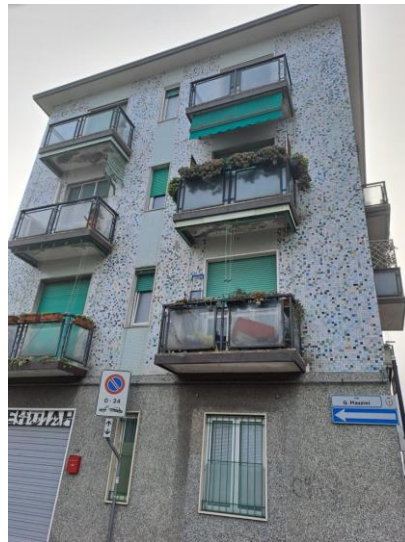
2. Facciata su via Mazzini (angolo)
