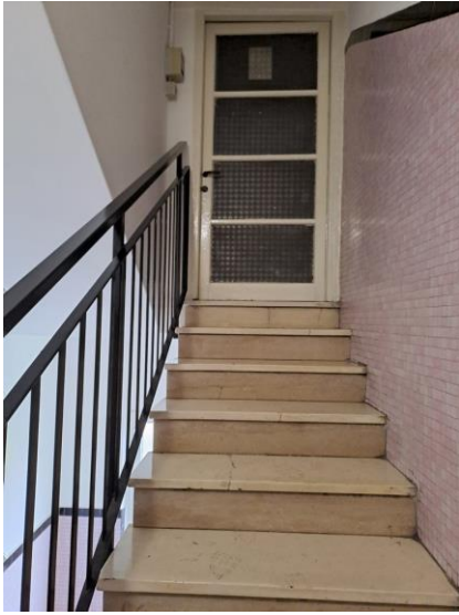
33. Accesso al piano 4° sottotetto (solai)
