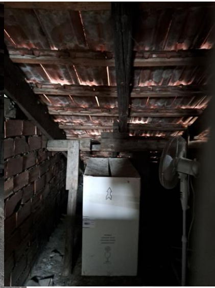
36. Interno del solaio
