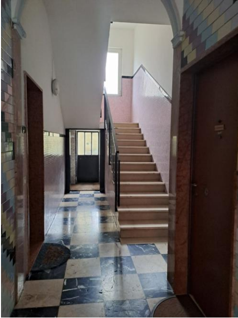
5. Androne di ingresso
