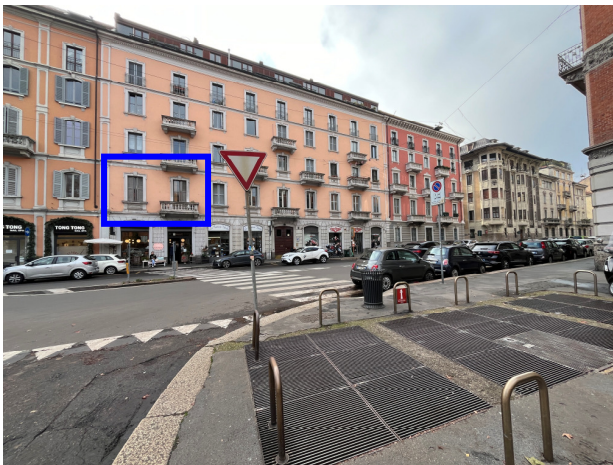
La facciata sulla via Guido D'Arezzo
