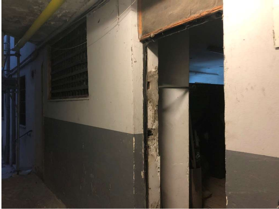
Porta e finestra magazzino piano interrato
