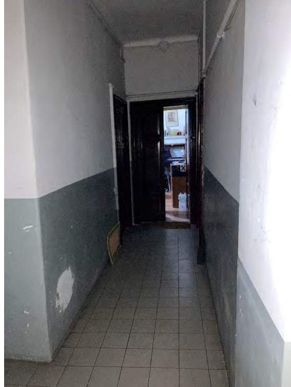
Foto n. 7: Pianerottolo comune al piano secondo
