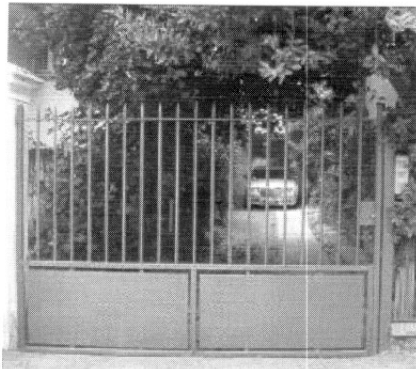
ingresso carraio su Via Baracca
