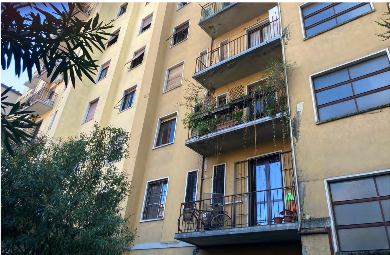
Foto 2 – Vista fabbricato condominiale da cortile interno
