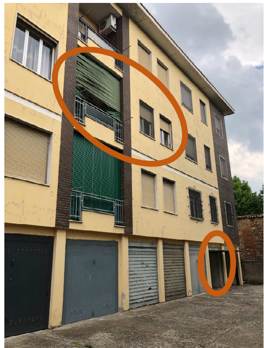
Facciata opposta all'ingresso >>appartamento 1°p e box
