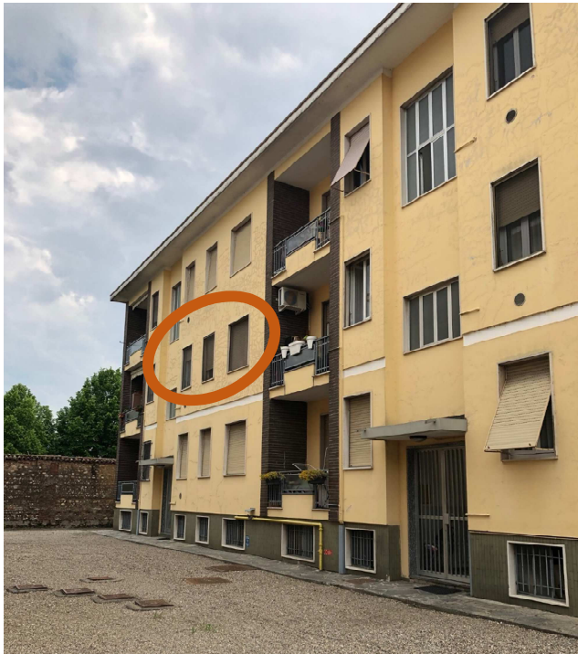
Facciata ingresso >>appartamento 1° p
