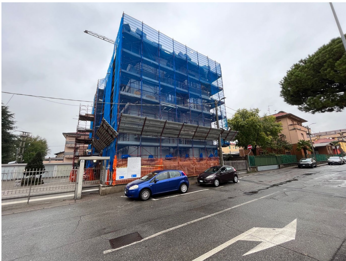
Immagine 1. Vista dalla pubblica via del fabbricato in cui si trova l'unità oggetto di valutazione; sono in corso lavori di efficientamento energetico.
