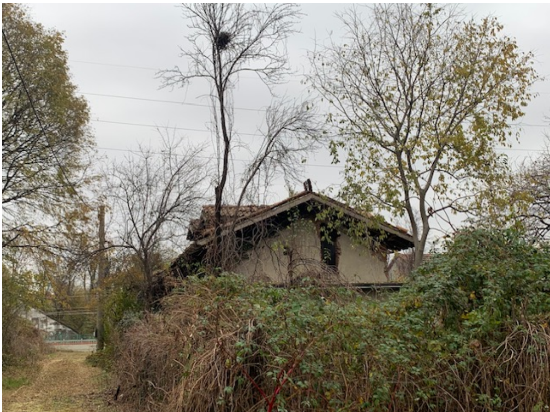
FOTO ESTERNA – EDIFICIO DI RIFERIMENTO E TERRENO
