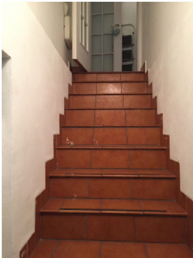
Foto 35 - Scala accesso al piano cantinato
