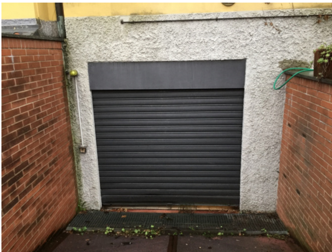
Foto 42 - Box e rampa di accesso dal piano terra
