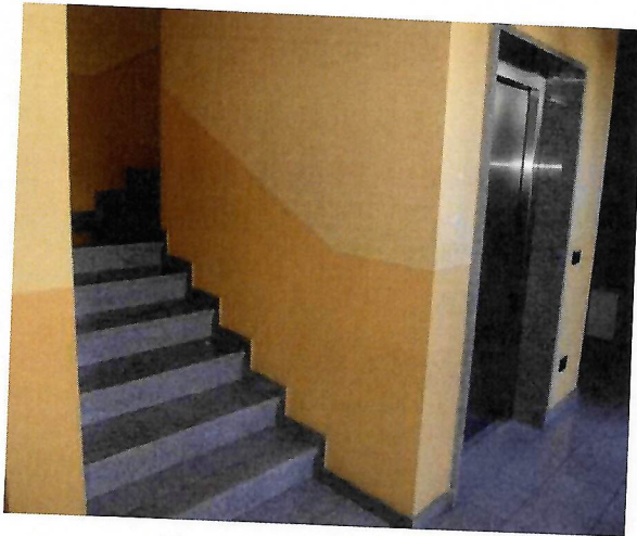
Viste vano scala ascensore
