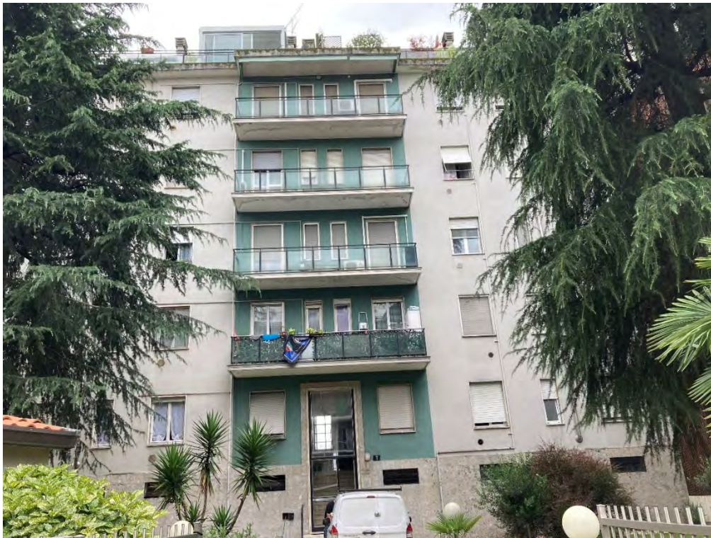
Foto n. 2: Prospetto principale su Via Vincenzo Monti
