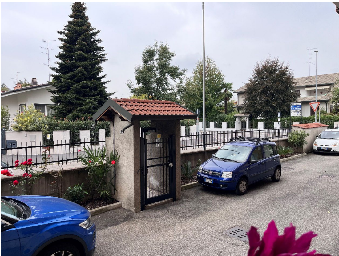
Immagini 1, 2 e 3. Il fabbricato visto dall'esterno con in evidenza, nella foto 2 le finestre dell'unità oggetto di valutazione. La foto 3 mostra l'ingresso al fabbricato dall'interno dell'unità oggetto di valutazione.
