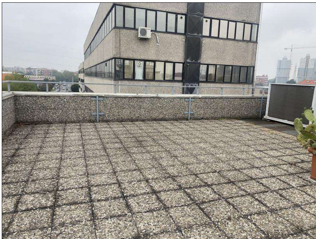
LASTRICO SOLARE – VISTA FOTOGRAFICA 45)
