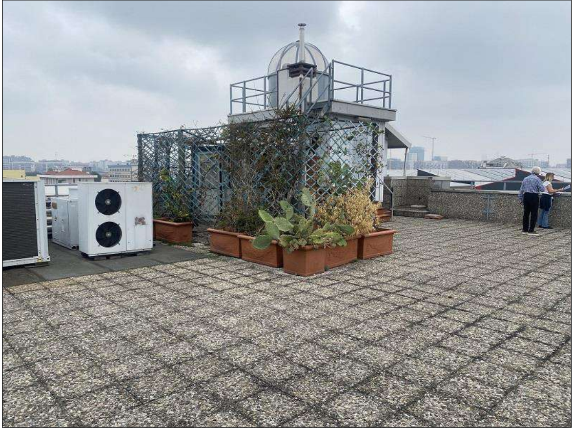
LASTRICO SOLARE – VISTA FOTOGRAFICA 46)
