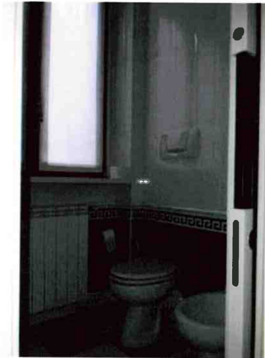
Foto A4. Piano rialzato: bagno
