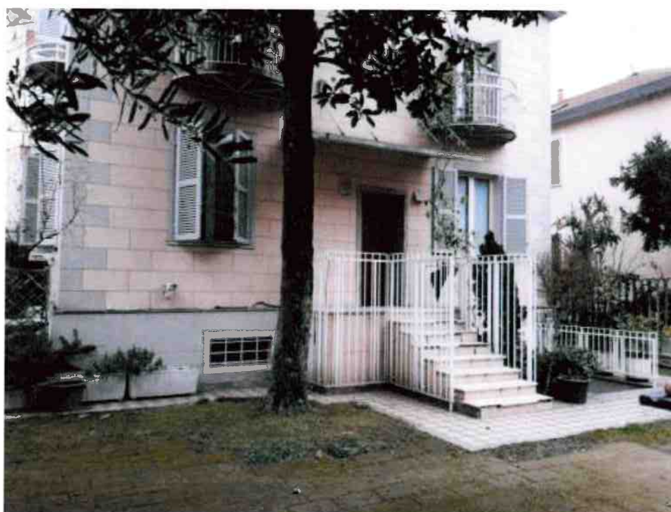
Foto 3. Prospetto ovest (Via Villa Mirabello)
