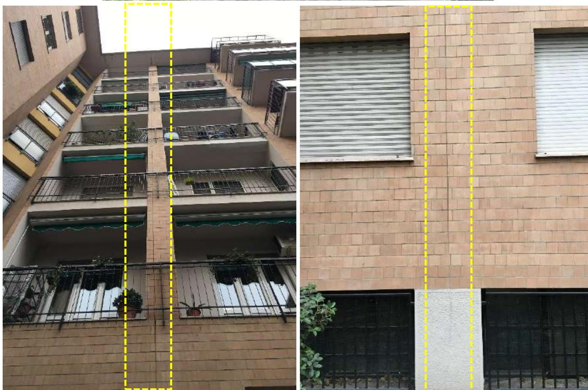
Figura 7 – particolare del giunto strutturale lato zona 3
