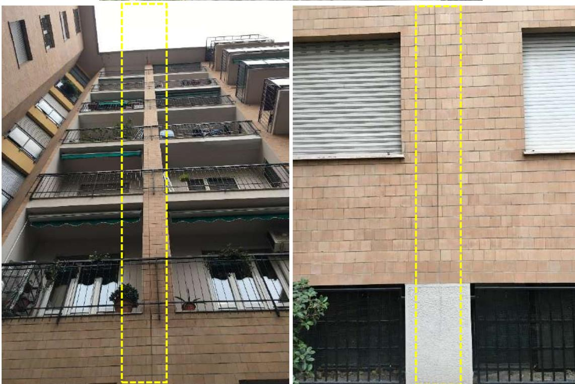
Figura 28 – particolare del giunto strutturale lato zona 3
