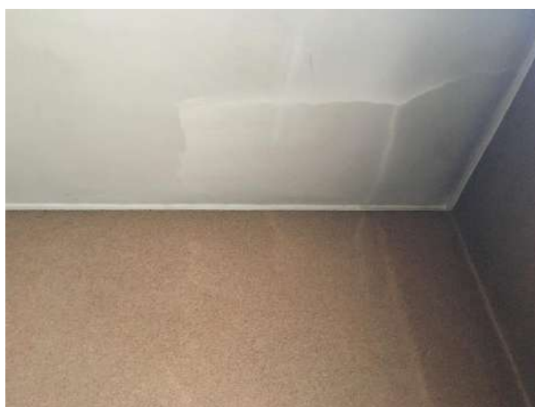
Figura 31 – intradosso di pianerottolo
