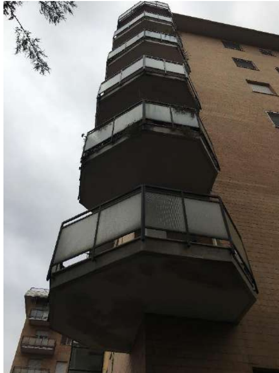
Figura 22 – angolo di facciata tra la zona 4 e la zona 5
