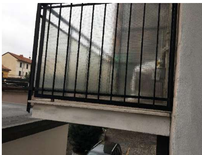
Figura 21 – facciata lato zona 4– dettaglio balcone
