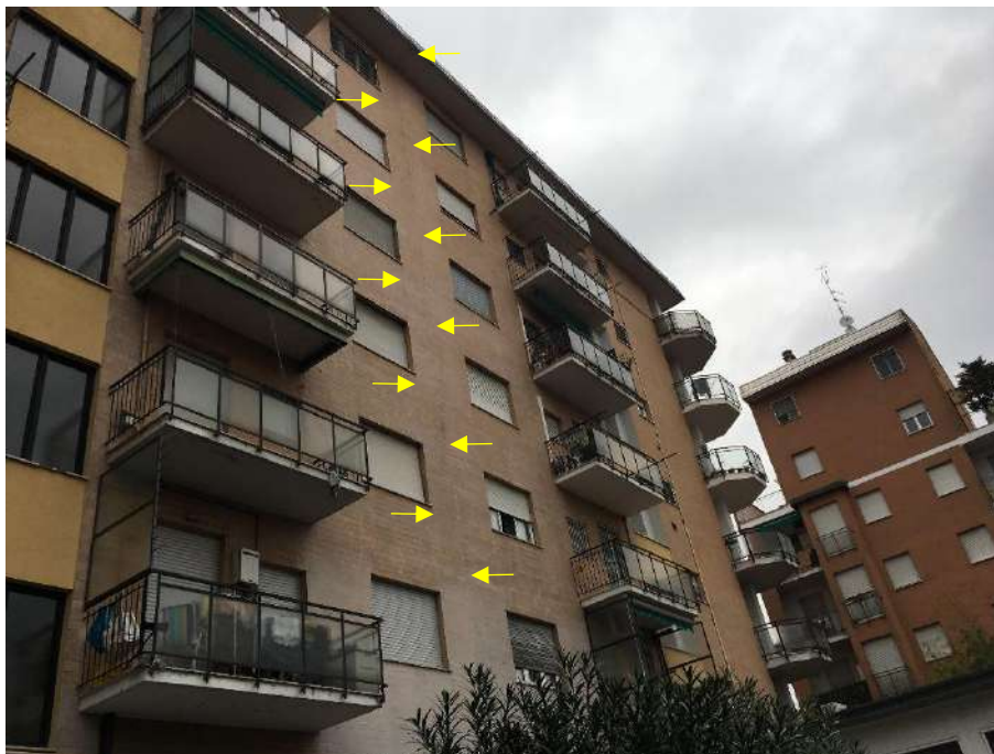
Figura 20 – facciata lato zona 4
