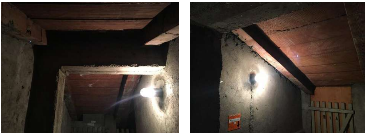
Figura 13 – struttura di copertura e “solaio”
