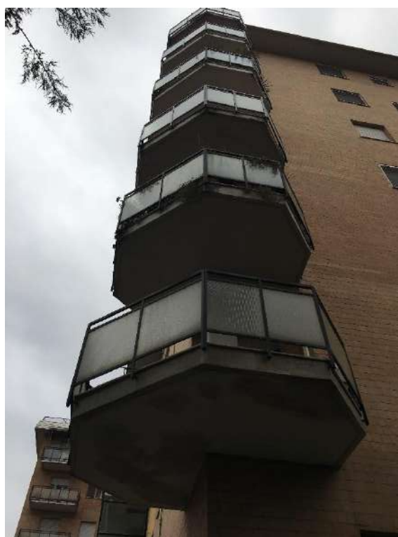
Figura 4 – angolo di facciata tra la zona 4 e la zona 5
