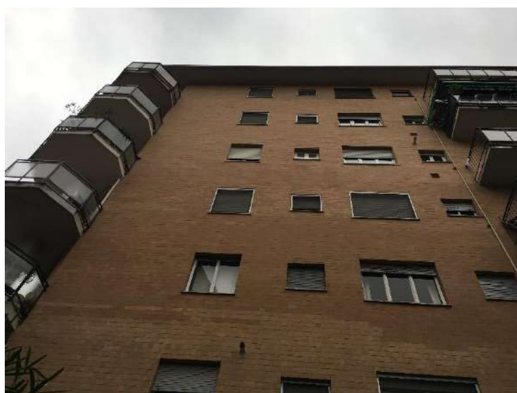
Figura 5 – facciata lato zona 5
