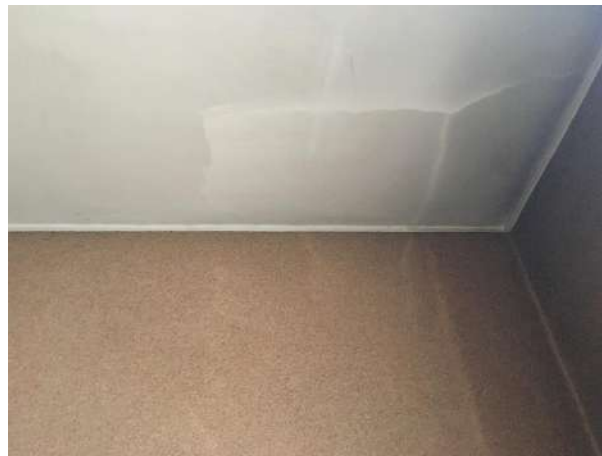
Figura 12 – intradosso di pianerottolo
