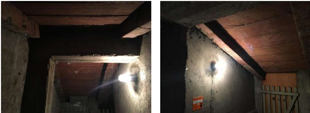
Figura 32 – struttura di copertura e “solaio”
