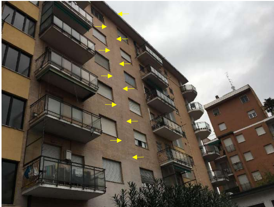
Figura 2 – facciata lato zona 4
