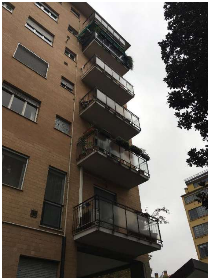
Figura 6 – facciata lato zona 5
