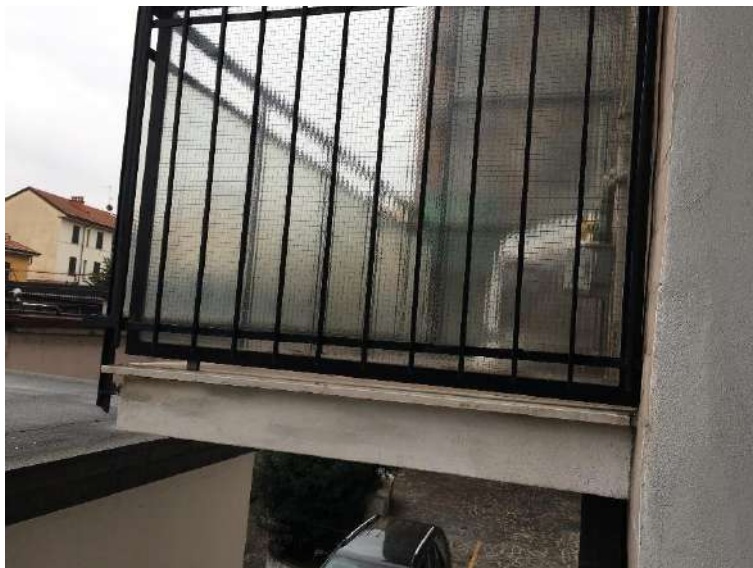
Figura 3 – facciata lato zona 4– dettaglio balcone
