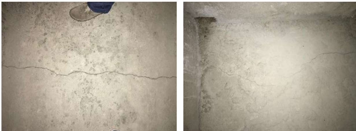
Figura 15 – giunto su impalcato del sottotetto
