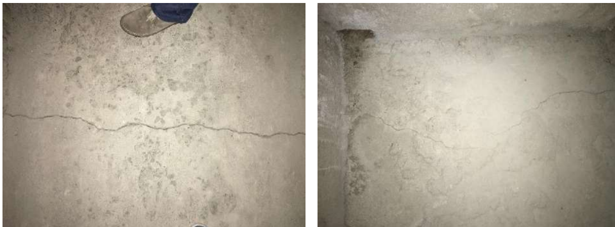
- Figura 28 – giunto su impalcato del sottotetto
