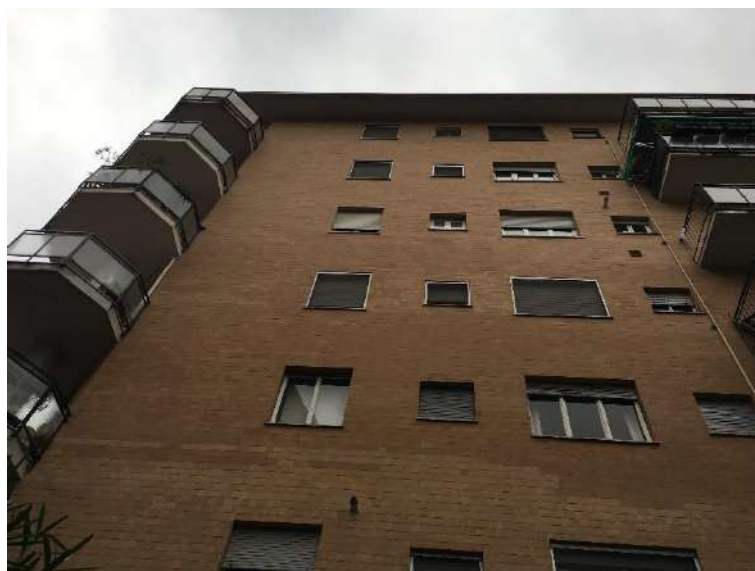
Figura 23 – facciata lato zona 5
