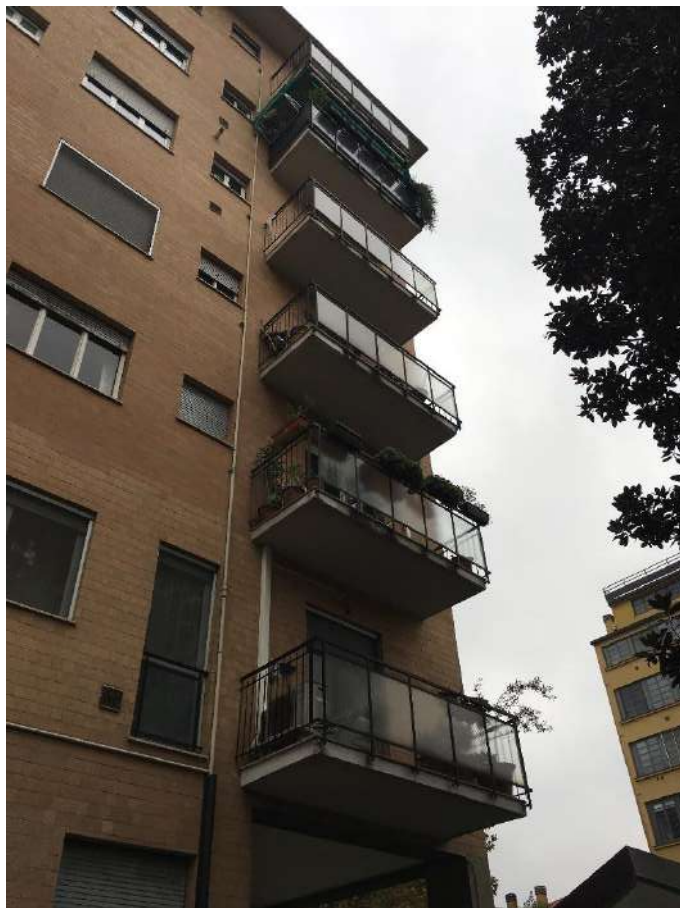
Figura 24 – facciata lato zona 5
