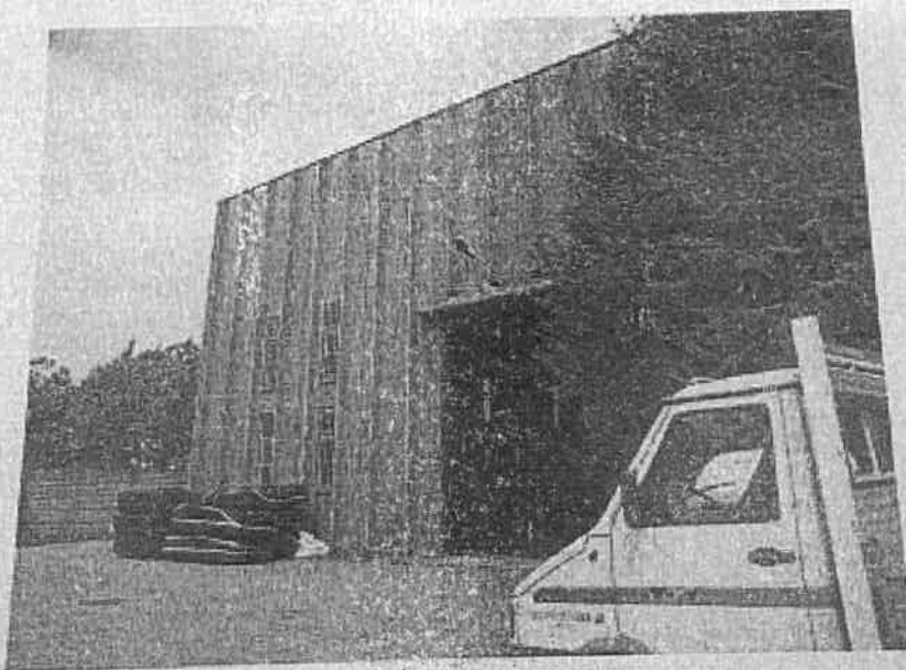
FOTO 8 – Vista prospetto sud
