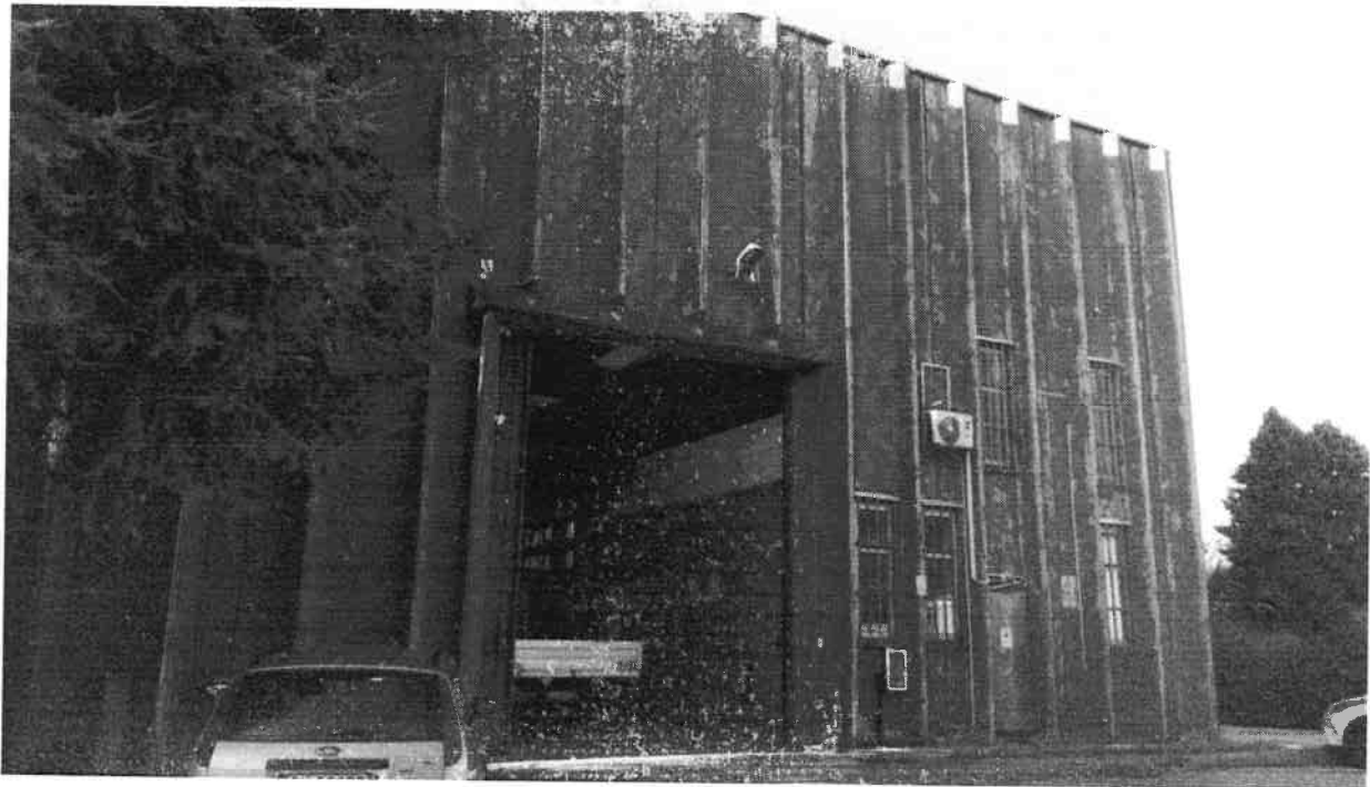
facciata principale sud con ingresso al subalterno 704
