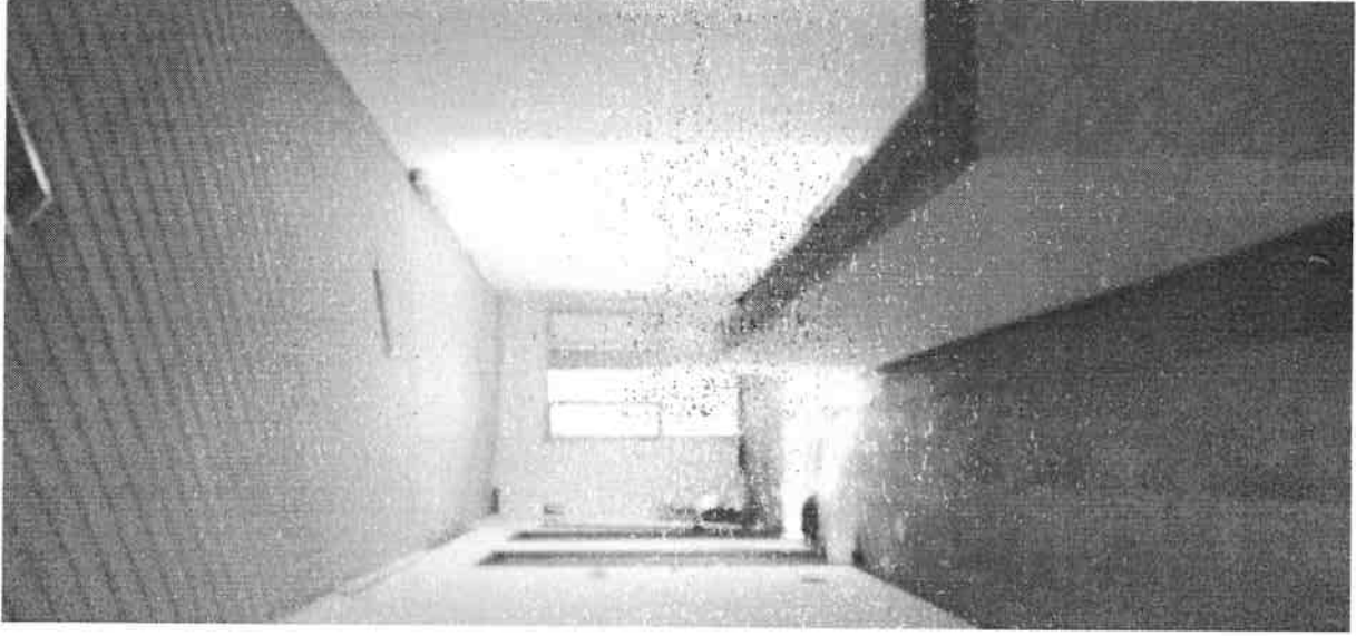
FOTO 16 – DISIMPEGNO SCALE P.1°
