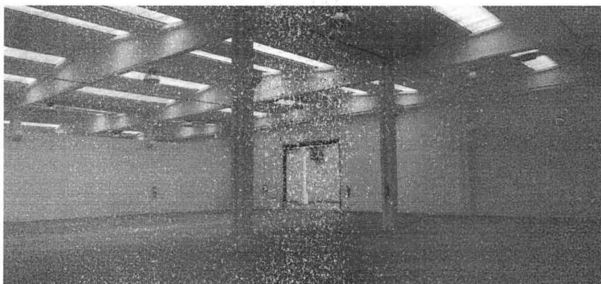
FOTO 3 – INTERNO CAPANNONE VERSO SUD-EST – A DX PARETE DA DEMOLIRE
