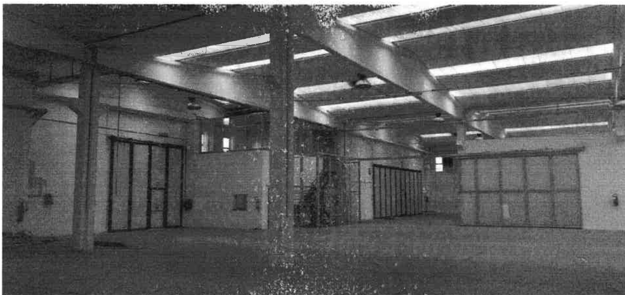
FOTO 1 – INTERNO CAPANNONE VERSO NORD
