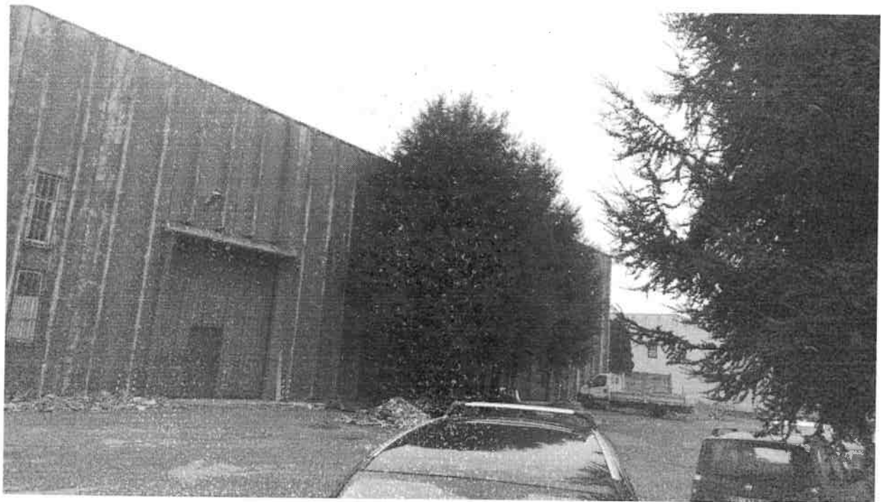
facciata principale sud con ingresso al subalterno 703
