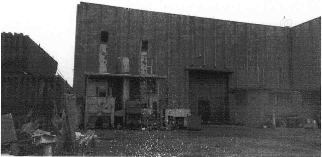
facciata posteriore nord subalterno 704
