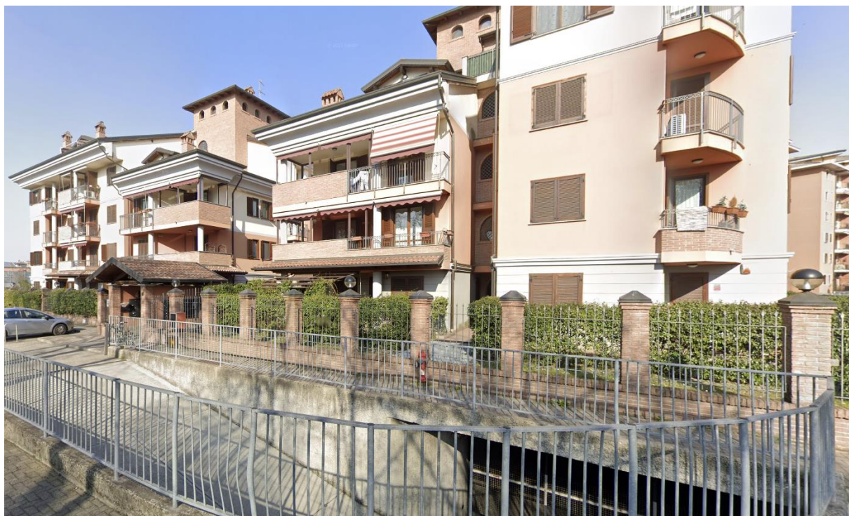
FOTO 01 – Vista esterna del fabbricato – prospetto viale Indipendenza
