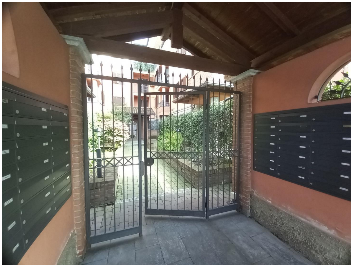
FOTO 02 – Accesso al fabbricato – dal cortile interno comune
