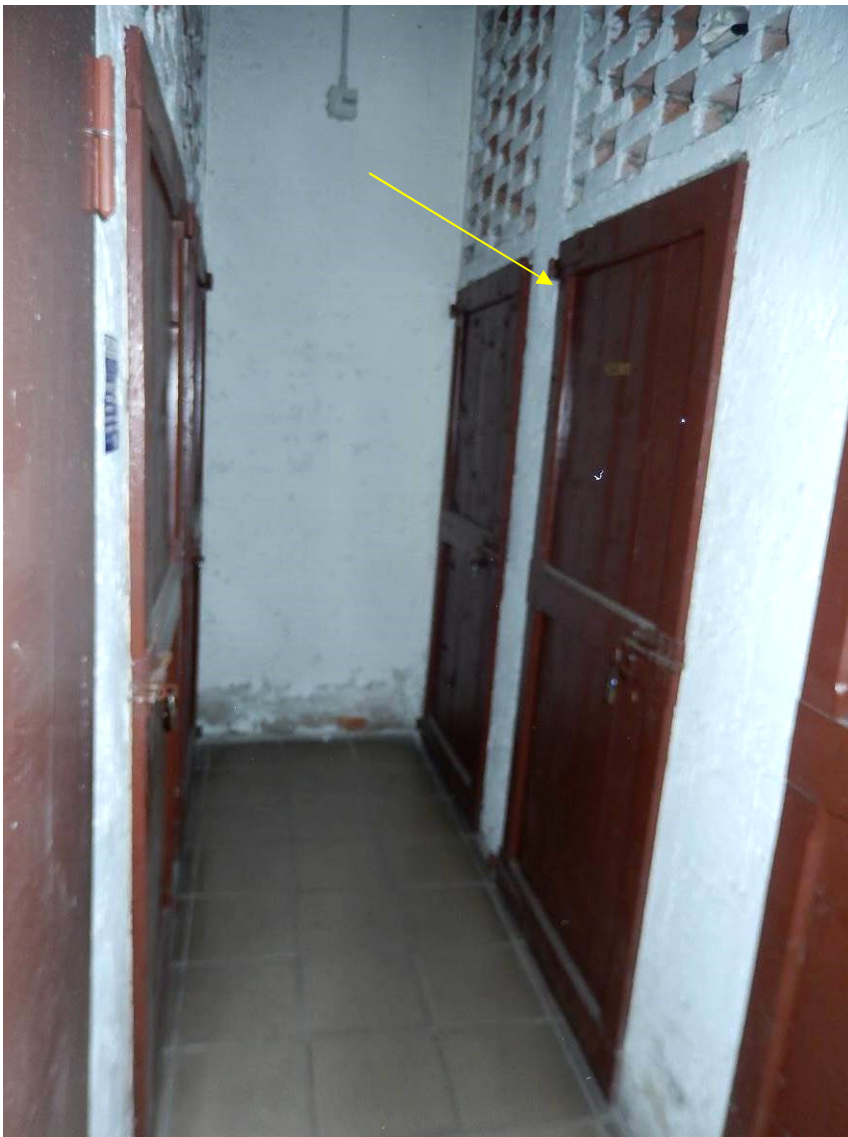
Foto 17 – Il corridoio cantine. Indicata dalla freccia la cantina annessa all'unità in esame.
