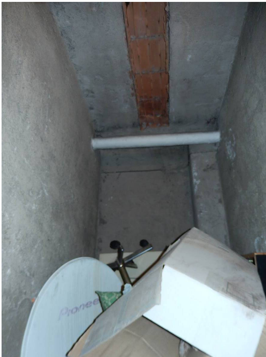
Foto 18 – Vista parziale dell'interno della cantina.
