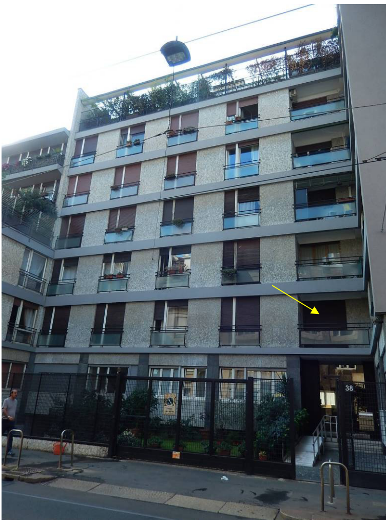
Foto 2 – Vista della facciata principale. L'unità in esame è indicata dalla freccia.
