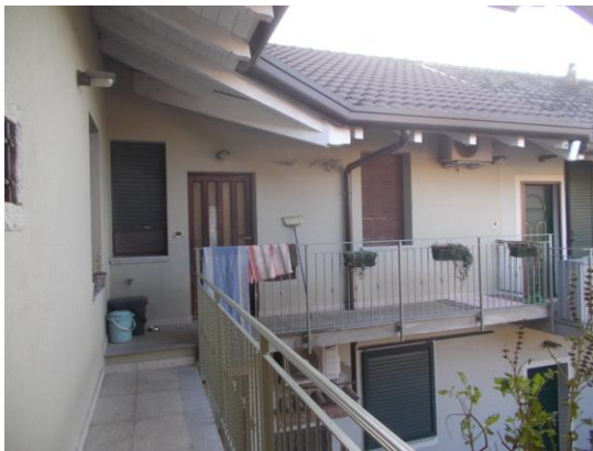
9. Immobile pignorato al sub 503
