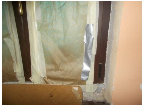
38. Sub 502: serramento della camera
