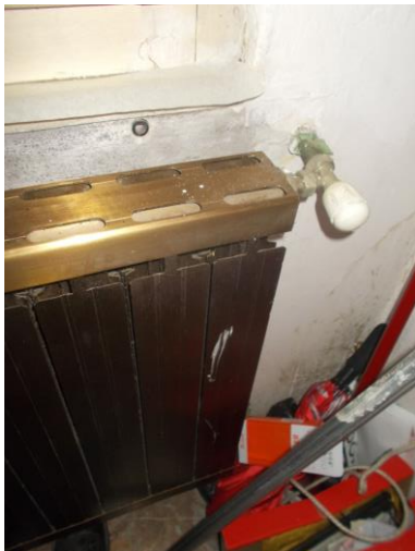
25. Sub 503: calorifero della camera
