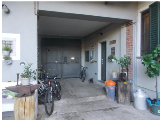
2. Androne di ingresso dal cortile interno
