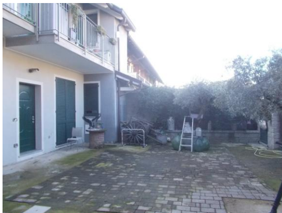
3. Cortile comune interno
