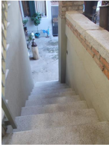
7. Scala esterna di accesso al piano 1°
