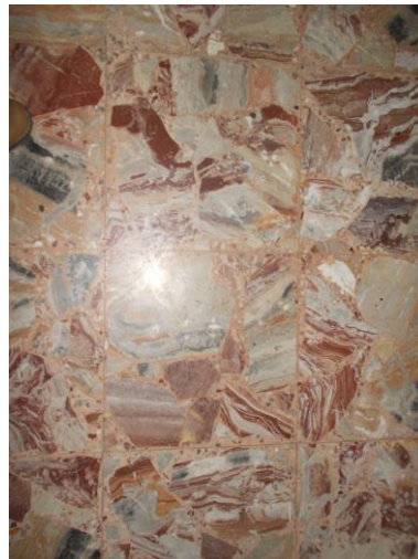
26. Sub 503: pavimento della camera
