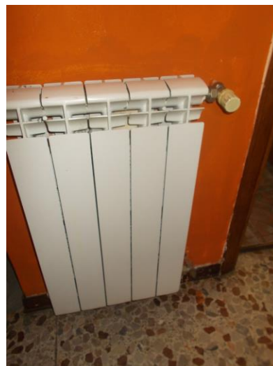
30. Sub 503: dettaglio calorifero soggiorno
