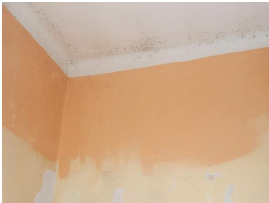
39. Sub 502: pareti e soffitto della camera
