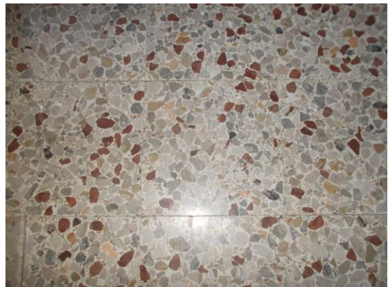
40. Sub 502: dettaglio del pavimento
