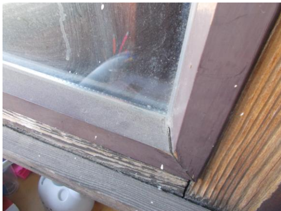
31. Sub 503: serramento esterno
