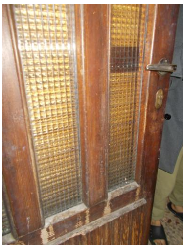
11. sub 503: portoncino di ingresso
