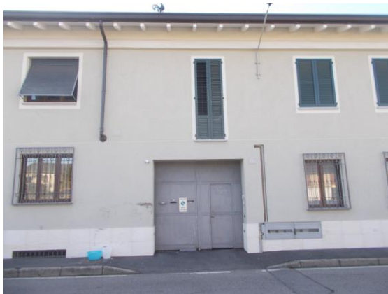
1. Facciata esterna su via Adua
