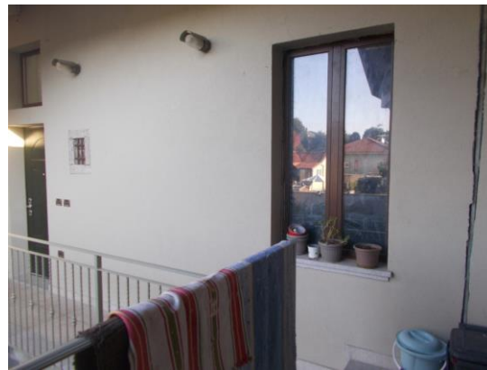
10. Immobile pignorato al sub 502
